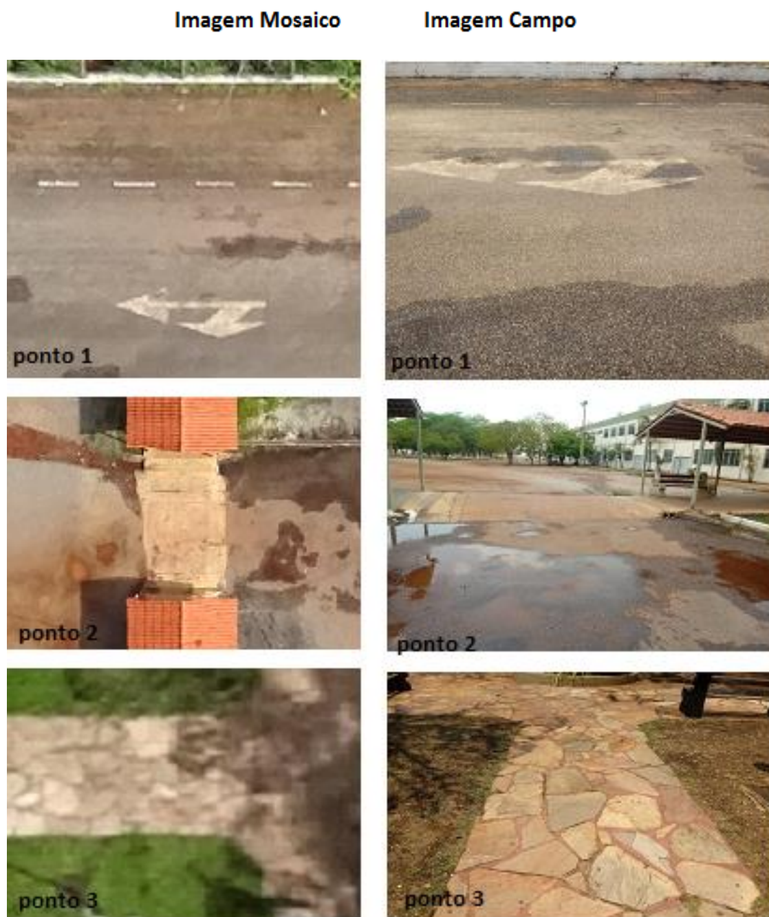
Figura 14: tipo de revestimento
