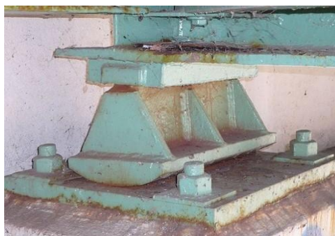
Figura 9- Aparelho de Apoio oscilante com contato linear
