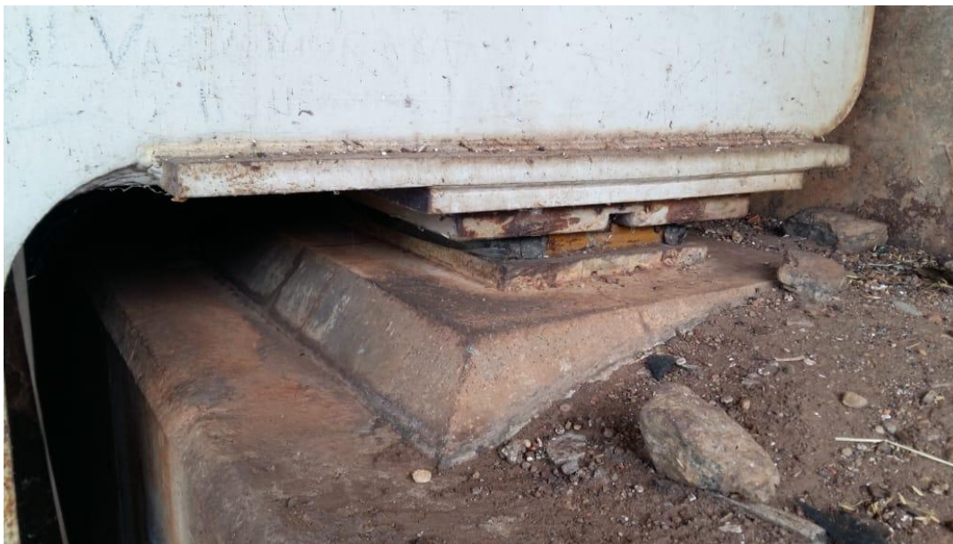
Figura 33-impurezas próximo ao aparelho
