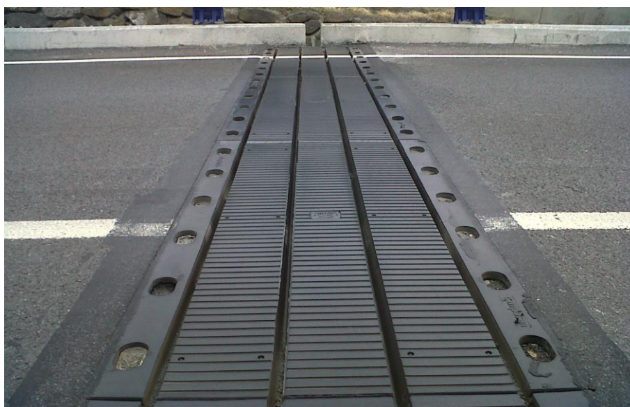
Figura 1- junta de dilatação
