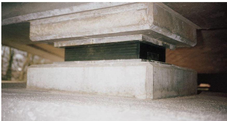
Figura 17- Aparelho de Apoio simples de Neoprene Cintado
