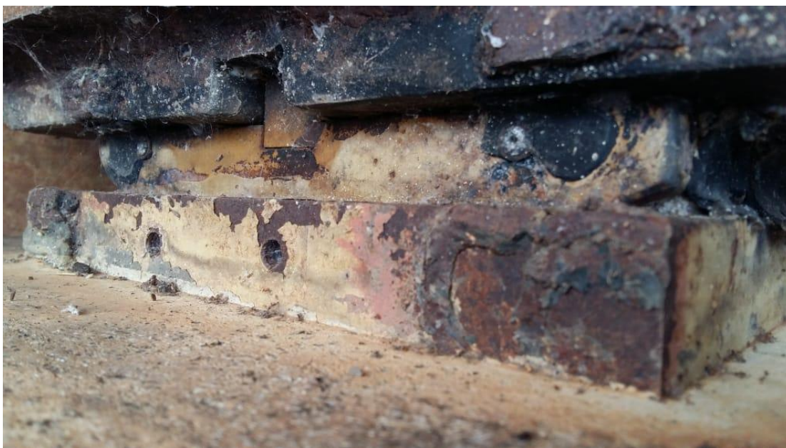
Figura 32-Aparelho com corrosão
