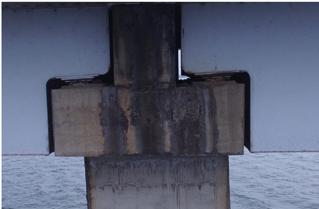
Figura 35-umidade próximo aos aparelhos
