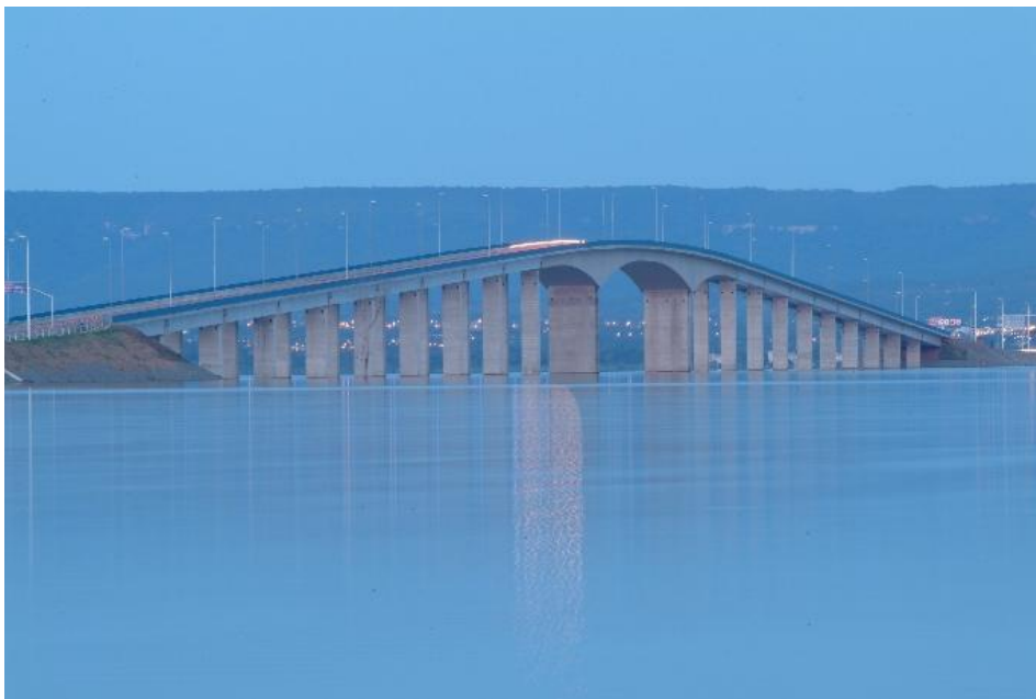
Figura 23- Ponte Fernando Henrique Cardoso
