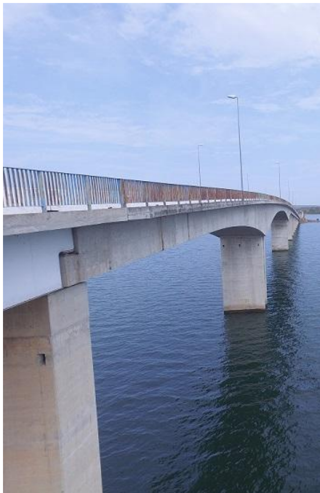
Figura 29- Pórtico da Ponte
