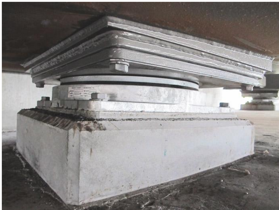
Figura 20- Aparelho de Apoio com receptaculo tip pote ou panela
