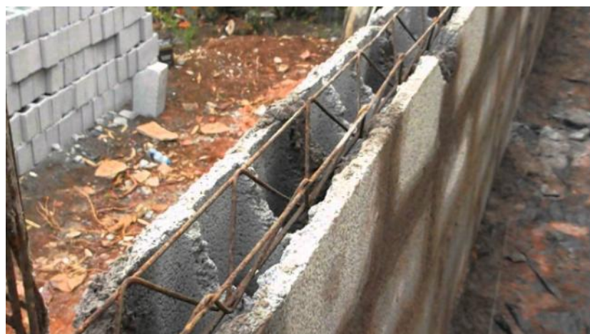
Figura 33: Execução de um Muro de Bloco Armado
