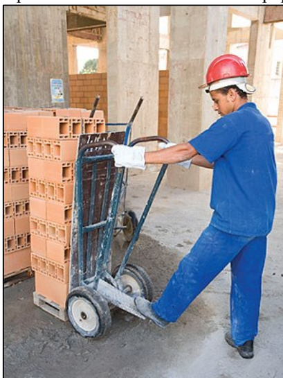
Figura 27 - Transporte de blocos cerâmicos com equipamento vertical
