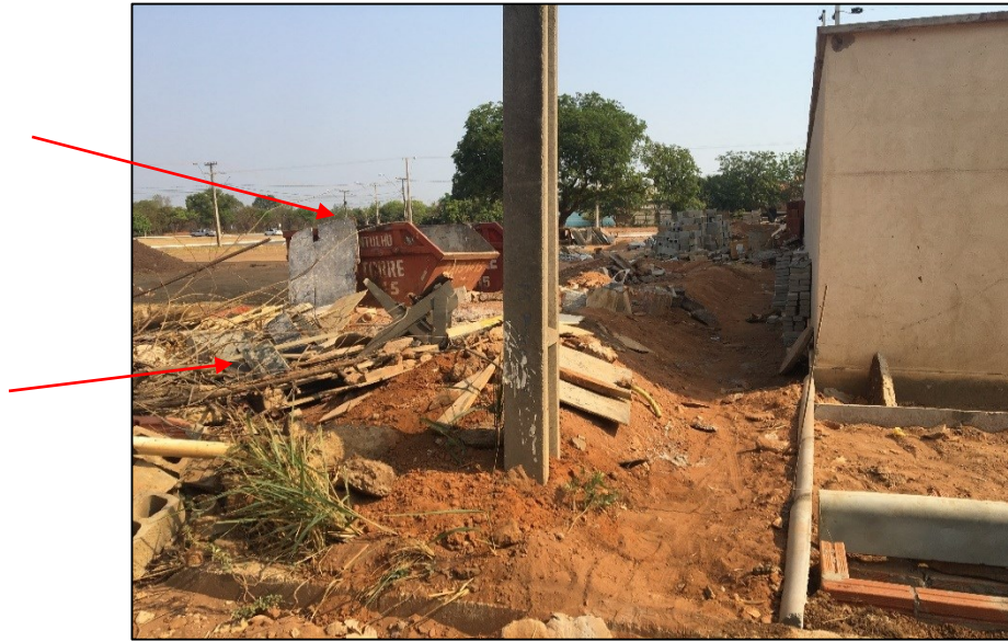
Figura 24 - Caçambas com entulho do lado de fora
