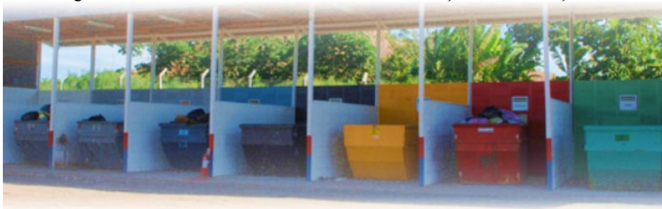
Figura 10 - Armazenamento de resíduos de construção civil em caçambas
