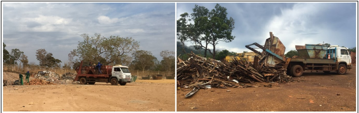
Figura 30 - Descarga de entulho na usina
