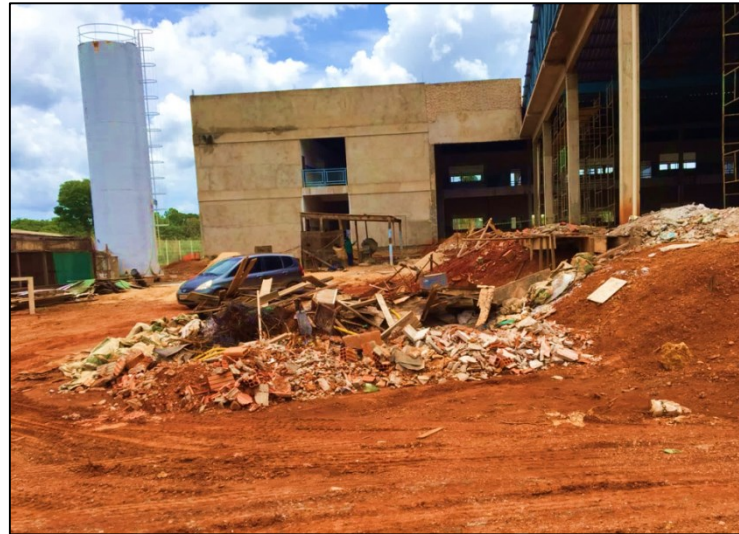
Figura 25 - Resíduos gerados provenientes da construção civil
