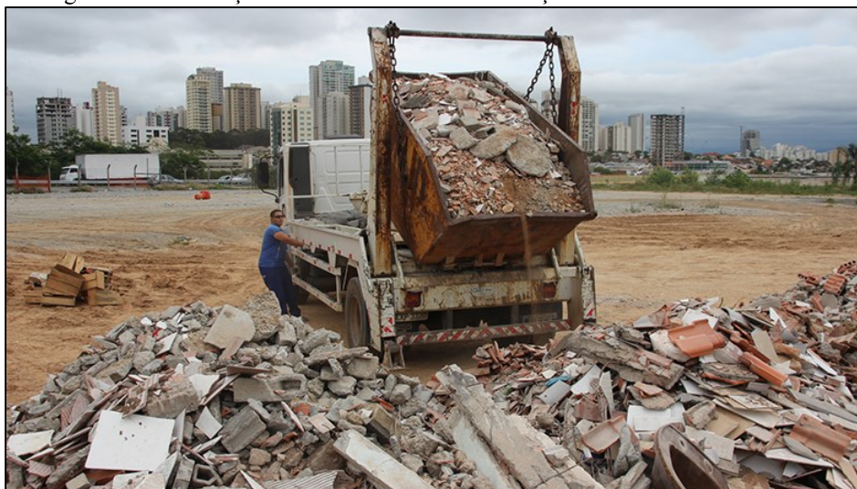
Figura 12 - Destinação final de resíduos de construção civil de classe A
