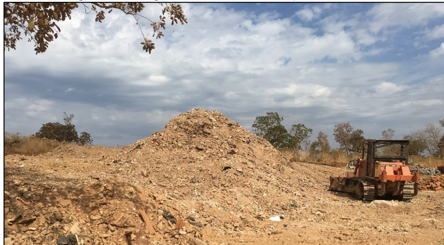
Figura 31 – Triagem de resíduo de construção civil
