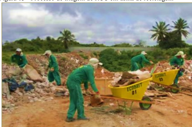
Figura 13 - Processo de triagem de RCC em usina de reciclagem
