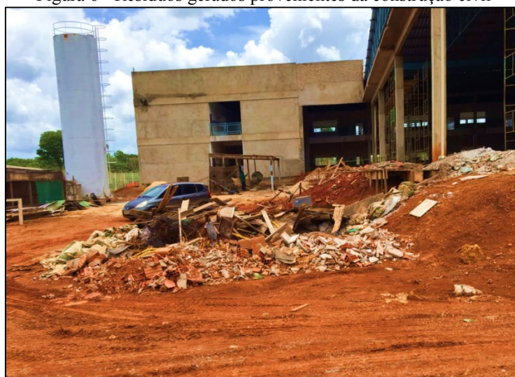
Figura 6 - Resíduos gerados provenientes da construção civil
