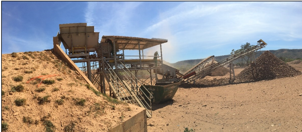
Figura 32 - Britador da usina de reciclagem de RCC de Palmas-To
