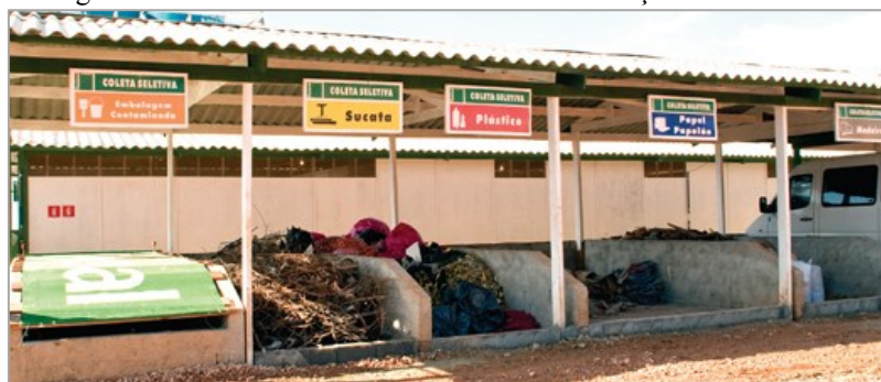
Figura 8 - Armazenamento de resíduos de construção civil em baias
