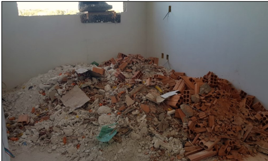
Figura 11 - Resíduos de diferentes classes (tijolos, sacos plásticos, papelão, gessos, etc.) misturados inadequadamente
