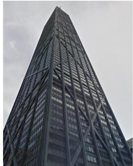
Figura 10 - À esquerda a ilustração do sistema com treliças alternadas ao longo do edifício. Já à direita segue a foto do edifício John Hancock de Chicago EUA, com sistema de tubo por treliças.
