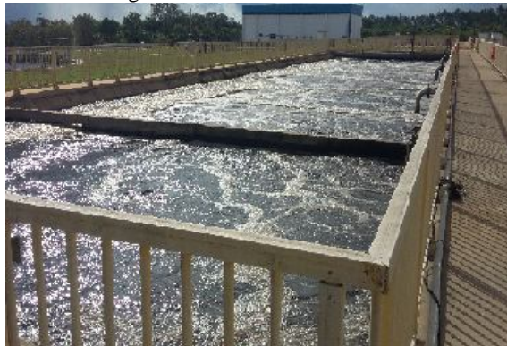
Figura 18: Reator de lodo ativado
