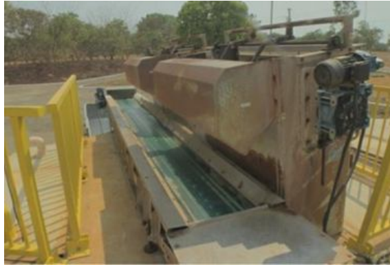
Figura 13: Gradeamento mecanizado
