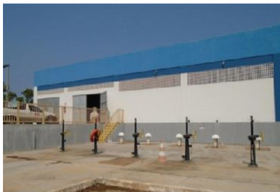
Figura 14: Estação elevatória de esgoto bruto
