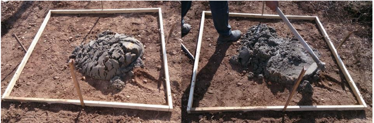
Figura 40: Espalhando a massa do contrapiso.
