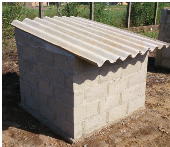
Figura 46: Telha fibrocimento (fachada Sul e Leste).
