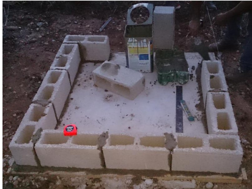
Figura 43: Assentamento da primeira fiada.
