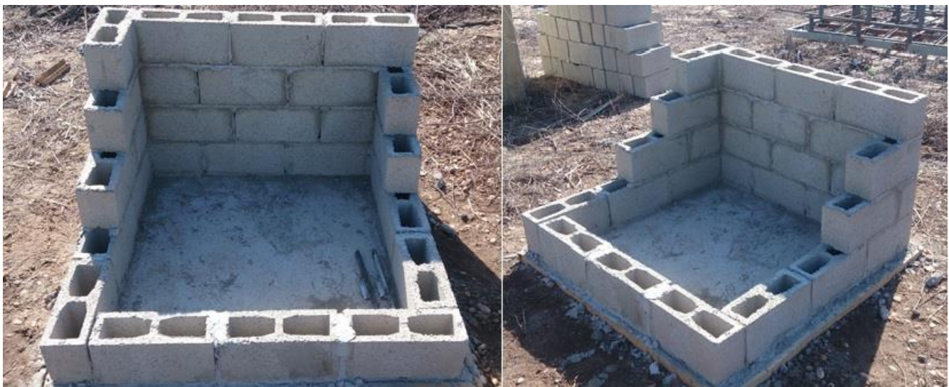
Figura 44: Assentamento dos blocos. A imagem mostra a construção de uma parede de blocos de concreto em duas perspectivas. A parede está sendo construída sobre uma base de argamassa e já possui algumas camadas de blocos assentadas.
