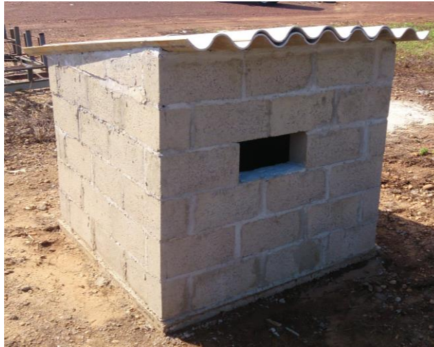
Figura 47: Fachada Norte e Oeste.
