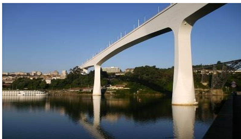
Figura 5 Ponte em pórticos
