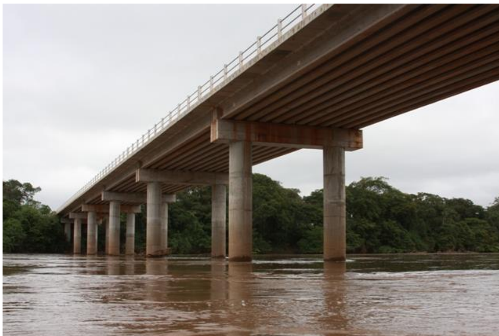
Figura 2 Ponte em viga de alma cheia
