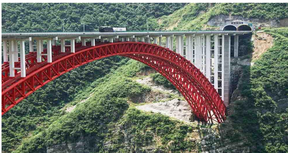
Figura 6 Ponte em arco
