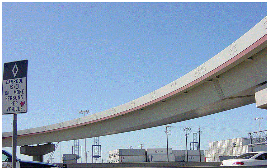
Figura 3 Ponte em viga caixão
