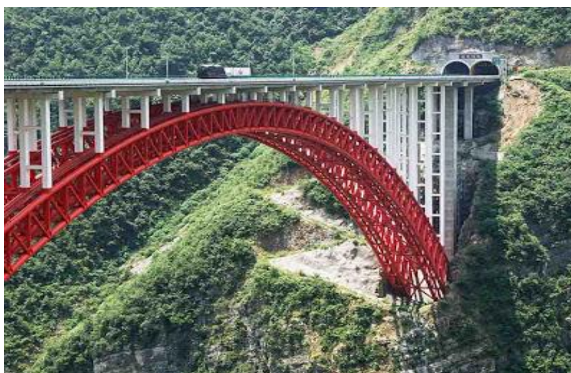
Figura 3 – Ponte Si Du River
