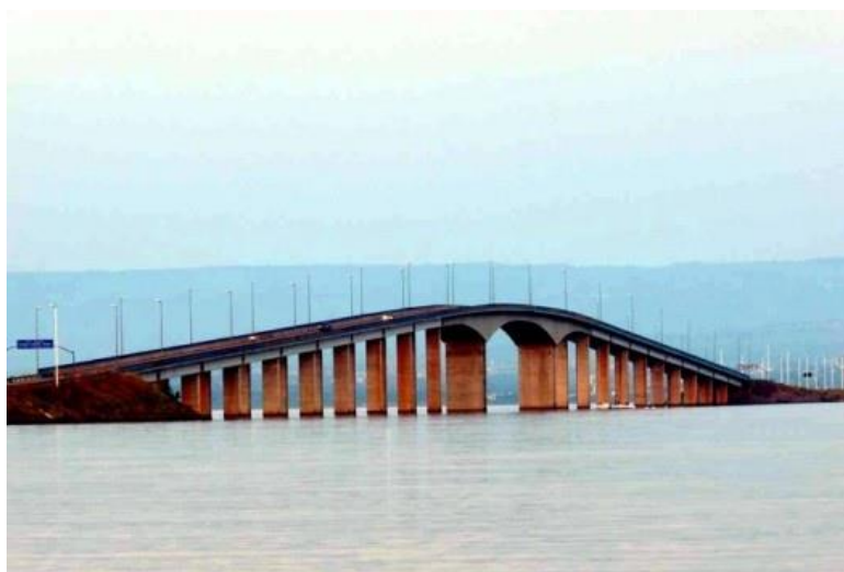
Figura 1 - Ponte Fernando Henrique Cardoso, Palmas.
