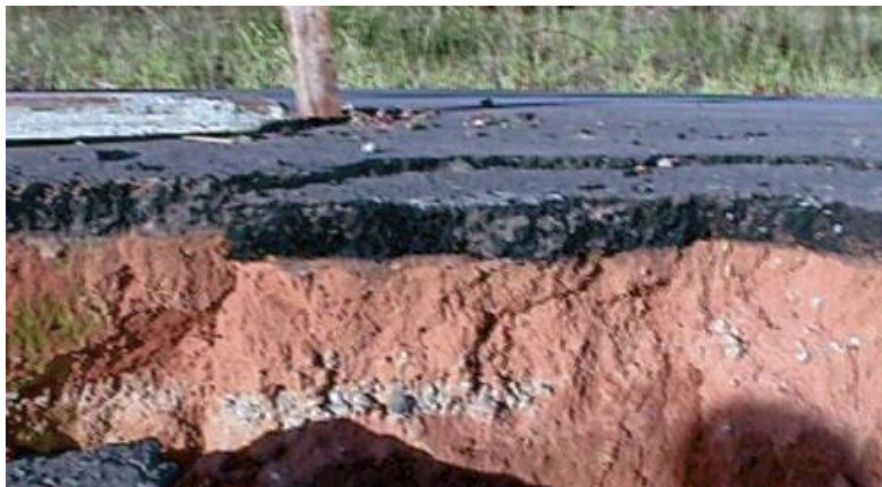
Figura 4 - Base estabilizada com cimento
