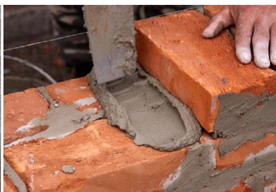
Figura 6: Assentamento de tijolos
