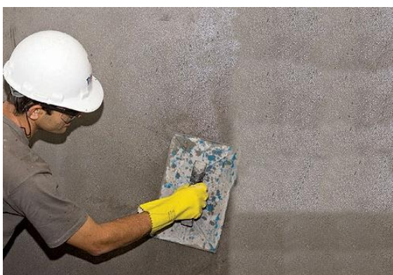
Figura 5: Aplicação de reboco
