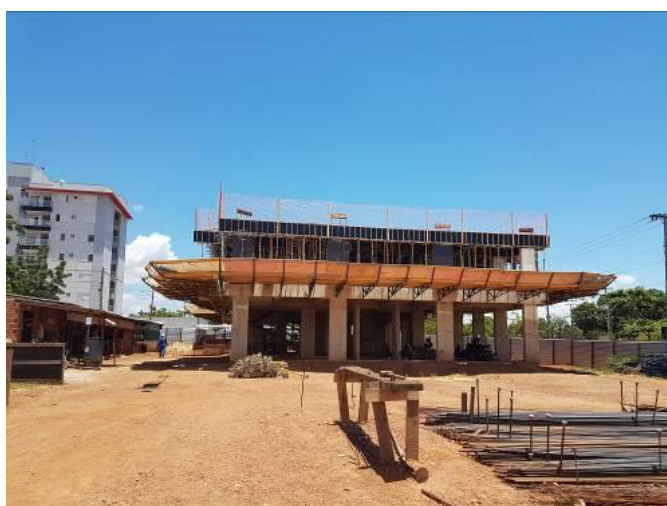
Figura 6: Superestrutura em construção
