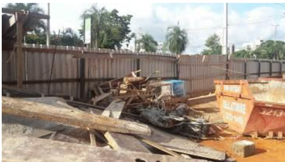
Figura 23: Local de armazenamento impróprio
