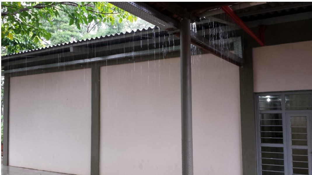
Figura 14 – Vista parcial do Bloco 7, em dia chuvoso, destacando a cobertura
