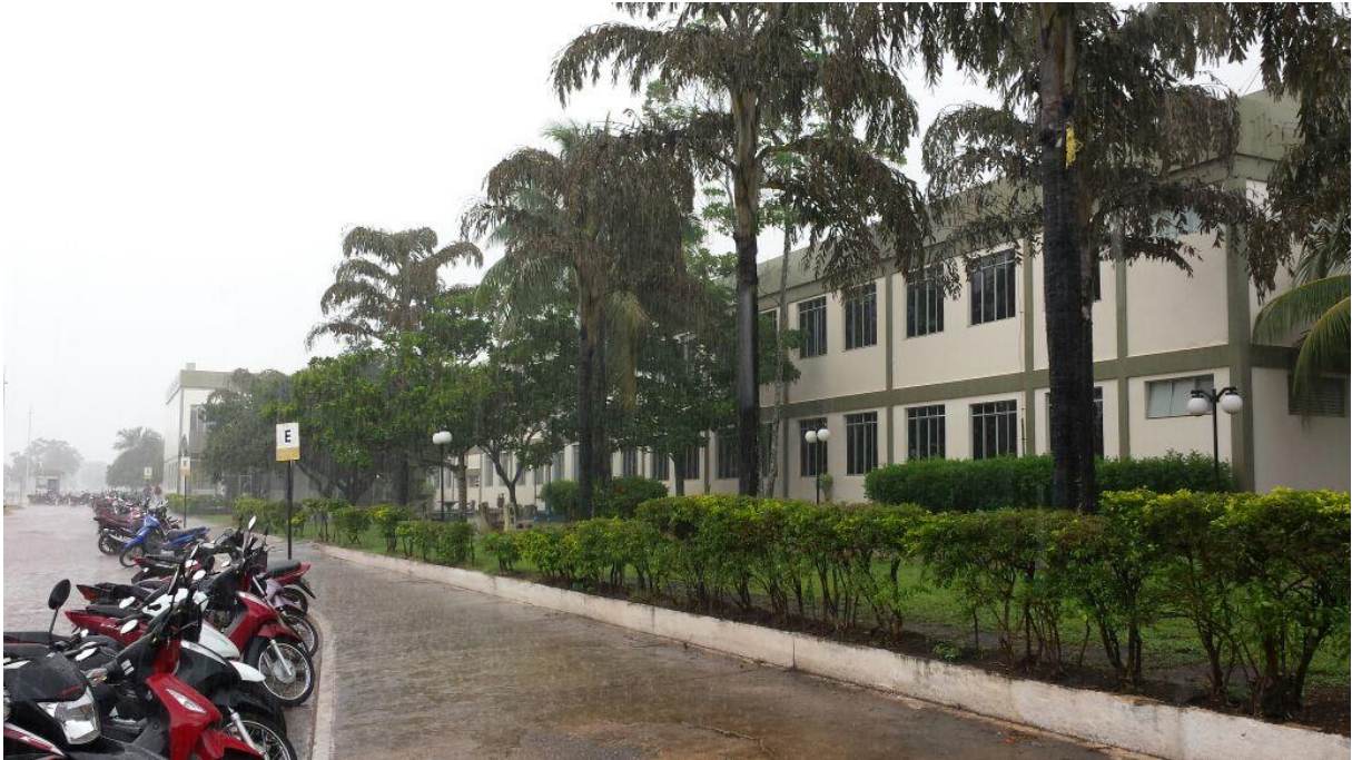
Figura 6 – Vista parcial do Bloco 2 e estacionamento do Ceulp-ULBRA em dia chuvoso
