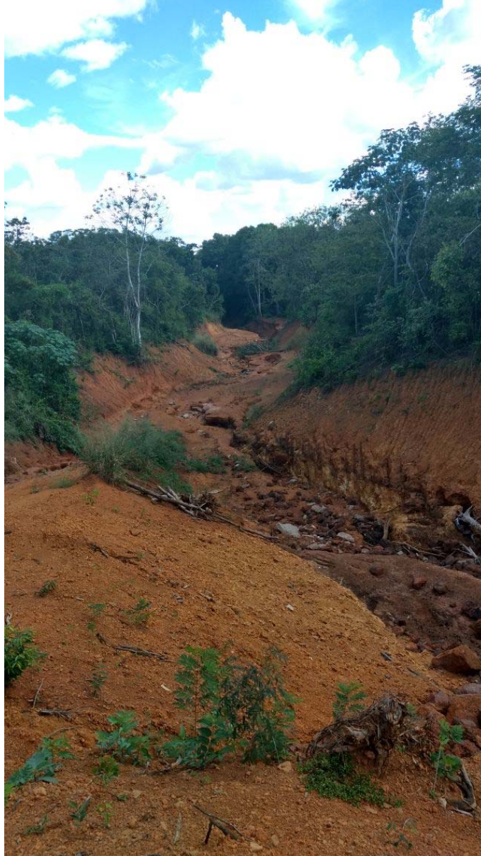
Figura 10 – Ponto 01 – Jusante galeria de drenagem urbana
