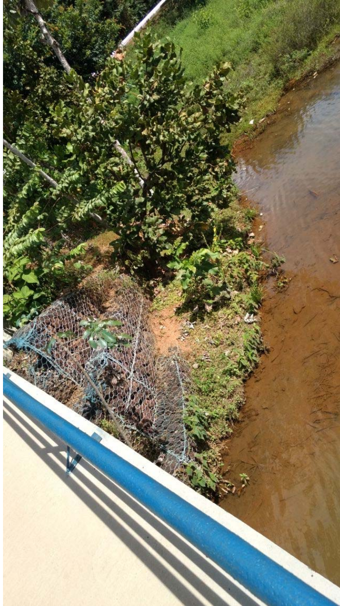
Figura 12 – Cabeceira de ponte em concreto armado
