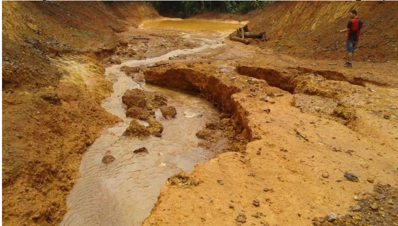
Figura 21 – Voçorocas cerca de 50m do dissipador de energia (13/11/2016)
