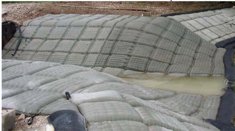
Figura 7 – Geotêxteis tecidos em forma de colchões preenchidos com argamassa
