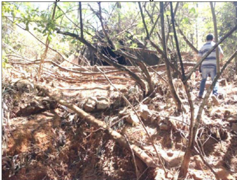
Figura 17 – Galeria de Água Pluvial
