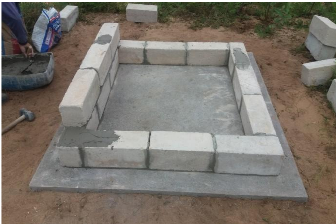
Figura 23 - Assentamento dos Blocos PET
