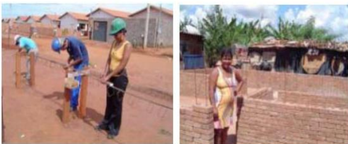
Figura 6- Mutirão para execução de casas utilizando solo cimento
