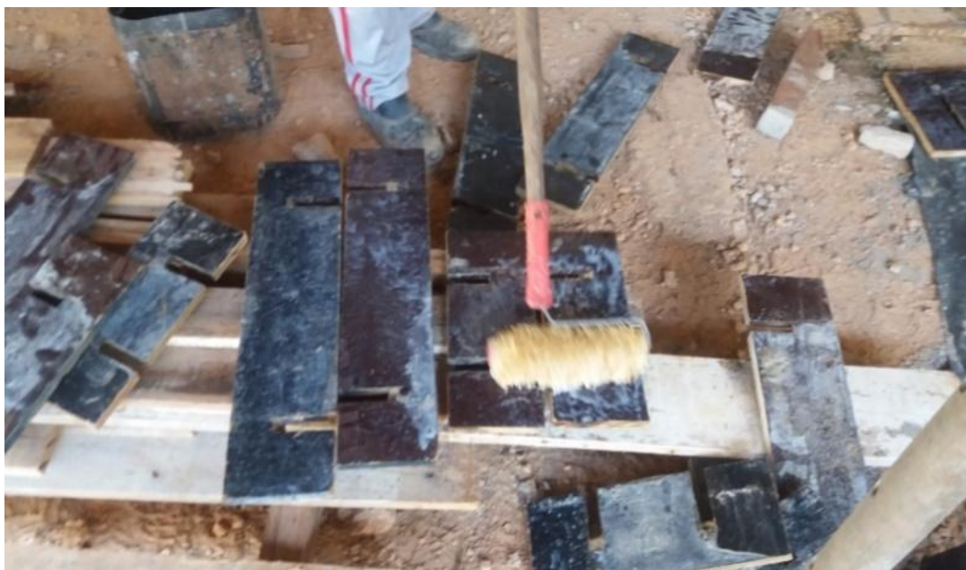
Figura 21 - Recortes das madeiras de compensado e aplicação de desmolde.
