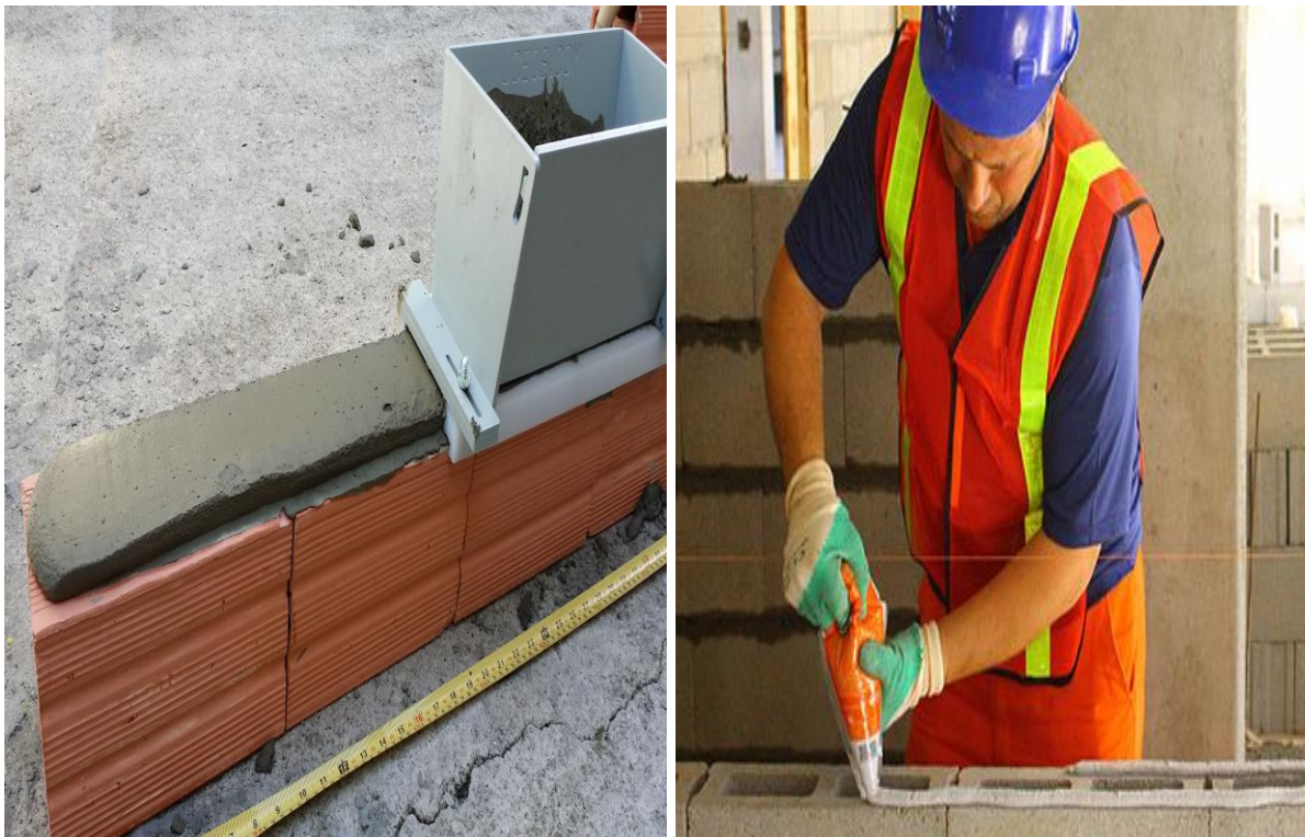
Figura 17 - Aplicação de Argamassa de Assentamento com Nivelador e Bisnaga
