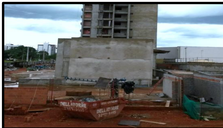
Figura 2: Vista do canteiro da obra.
