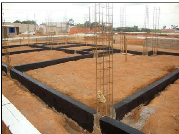
Figura 27 - Vigas baldrames, concretadas, desformadas e impermeabilizadas.
