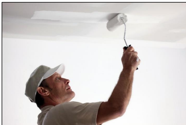
Figura 1332 - Aplicação de pintura - teto.
