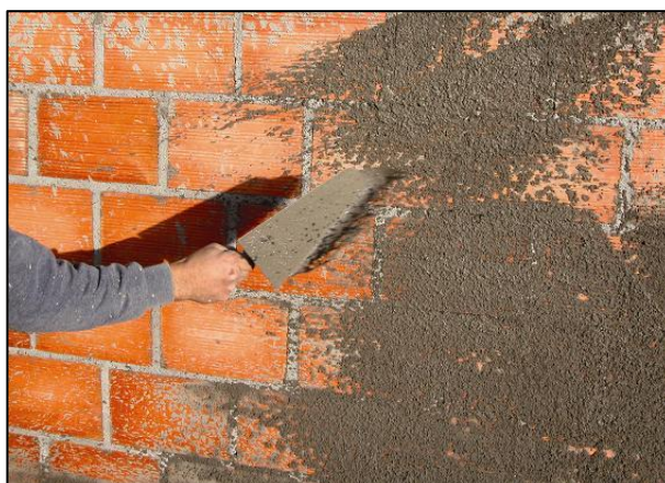
Figura 45 - Aplicação de chapisco em alvenaria.
