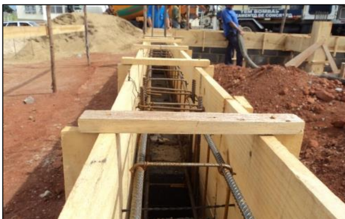
Figura 25 - Fôrmas para viga baldrame.
