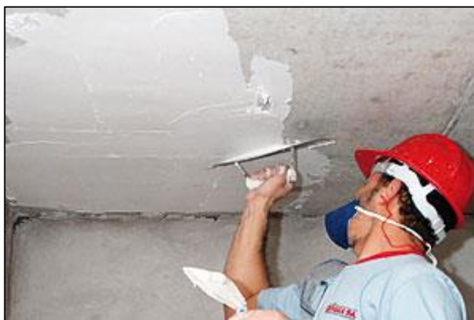
Figura 43 - Aplicação de massa niveladora.
