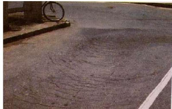
**Trinca tipo "Couro de Jacaré"**
