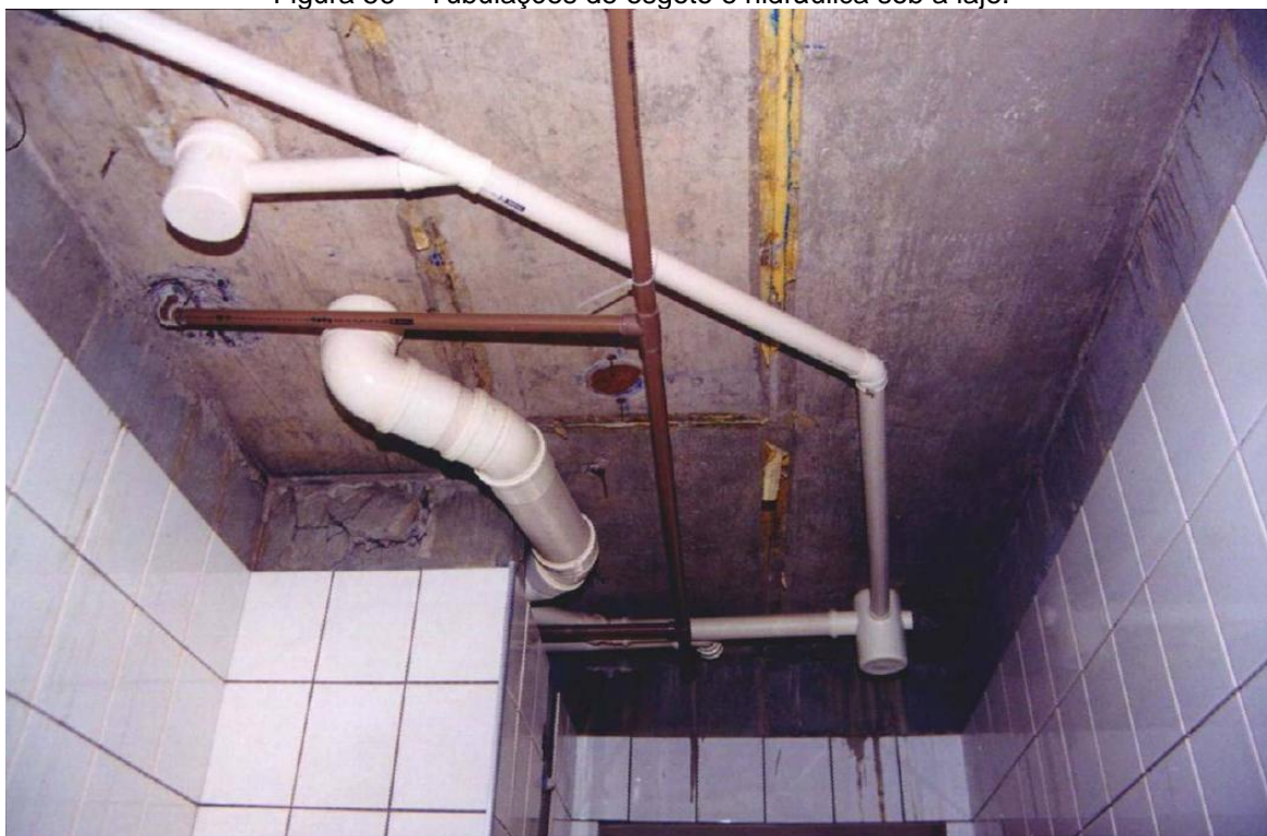
Figura 56 – Tubulações de esgoto e hidráulica sob a laje.
