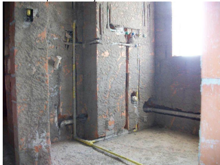
Figura 58 – Exemplo de tubulação hidráulica em alvenaria convencional.
