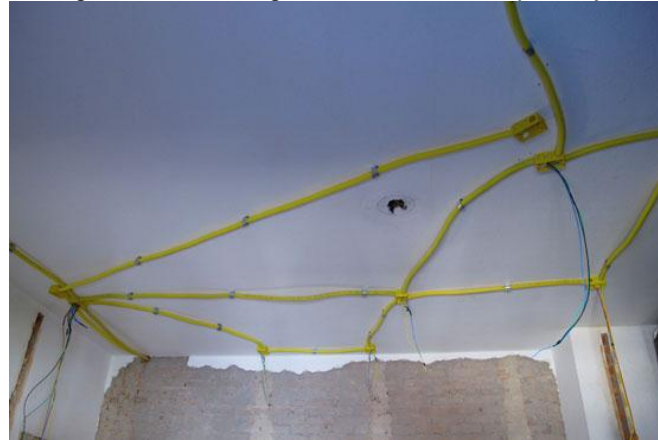
Figura 44 – Passagem dos eletrodutos pela laje.
