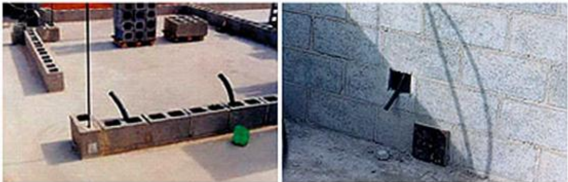
Figura 19 – Instalações embutidas nos blocos.
