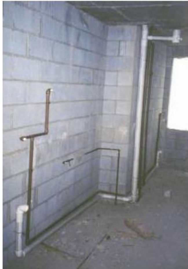
Figura 59 – Tubulações externas a parede.
