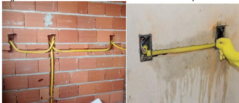
Figura 43 – Caixa elétrica fixada em alvenaria sem função estrutural.
