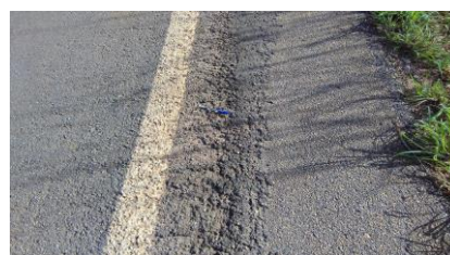
b) detalhe do pavimento
