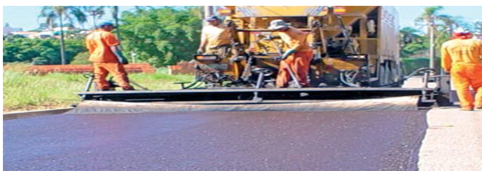
Figura 6– Exemplo de aplicação de lama asfáltica
