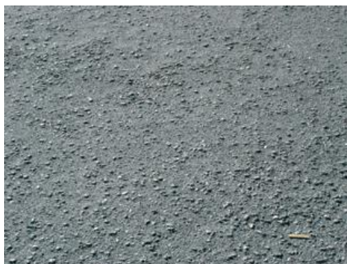
Figura 17- Desgaste
