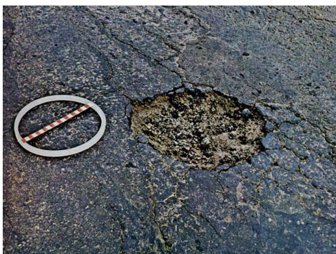
Figura 18– Panela / buraco
