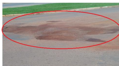
b) detalhe do pavimento
