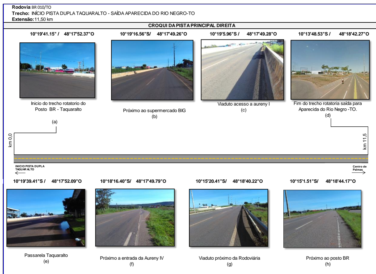
Figura 54-Pontos localizados do trecho
