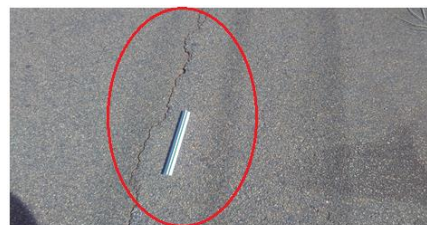
b) detalhe do pavimento
