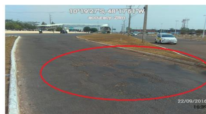
b) detalhe do pavimento
