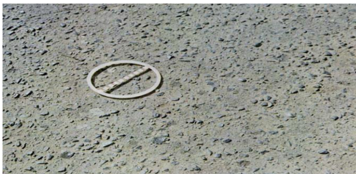
Figura 16- Desgaste
