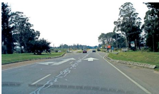
Figura 27 – Revestimento após selagem de trincas
