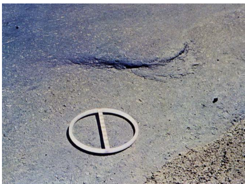
Figura 12– Foto escorregamento
