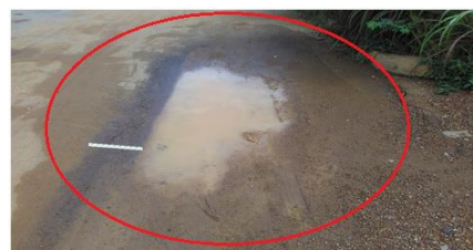
b) detalhe do pavimento
