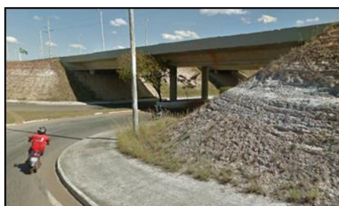
Figura 75-Condição viaduto rodoviária
