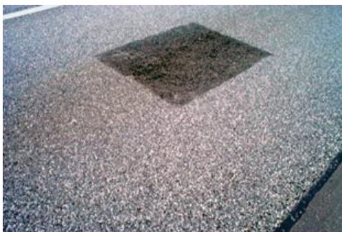
Figura 20– Remendo bem executado
