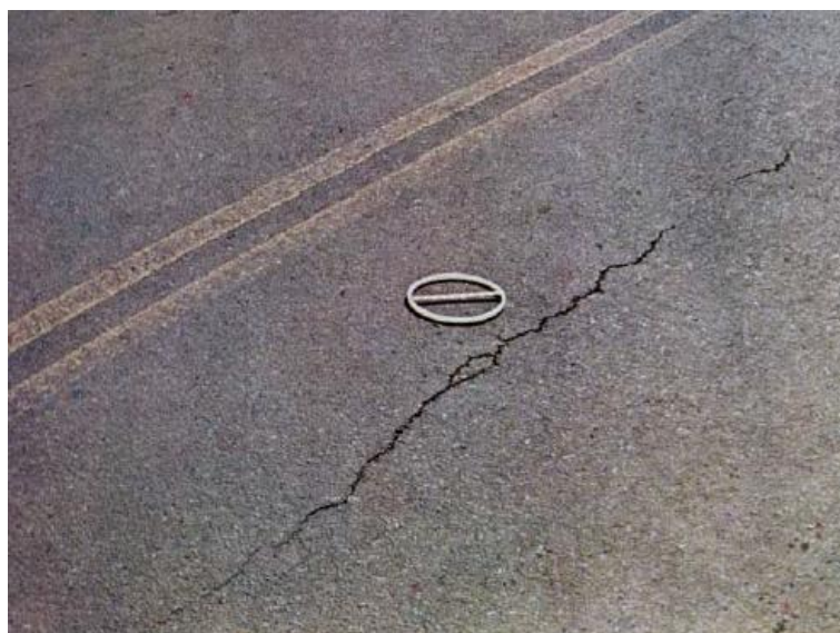
Figura 14 - Trinca Longitudinal
