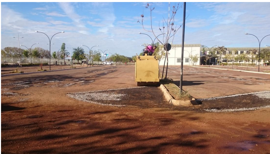
Figura 46 - Aplicação de Brita 1 e Compactação
