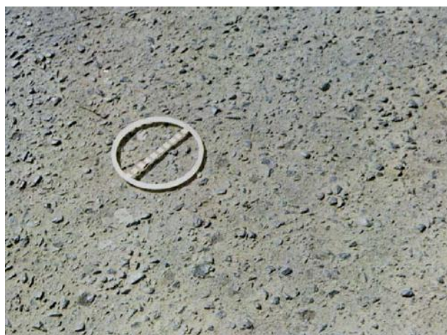
Figura 18 - Desgaste
