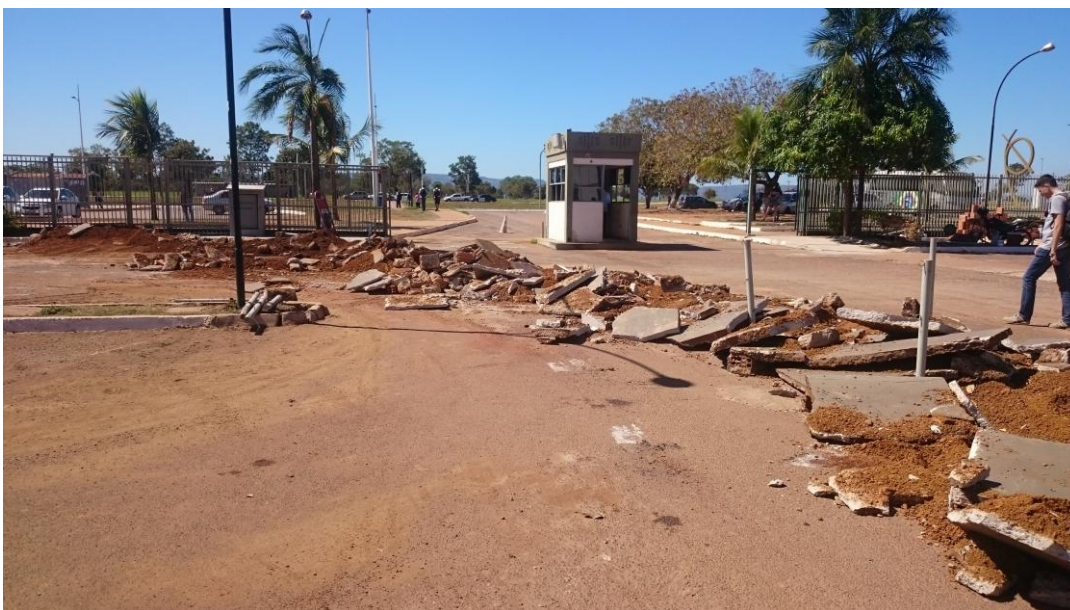
Figura 37 - Demolição Passarela Para Pedestres
