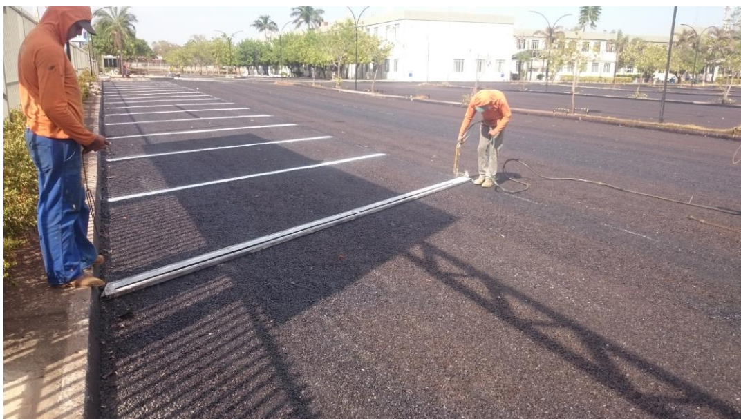
Figura 54 - Sinalização do Estacionamento
