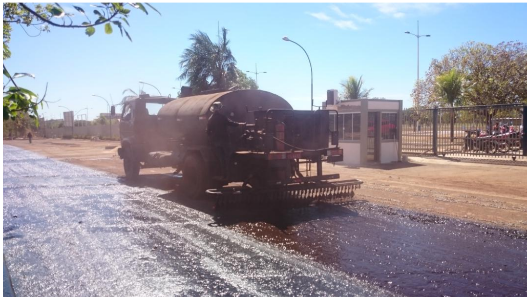
Figura 48 - Aplicação de RR-2C
