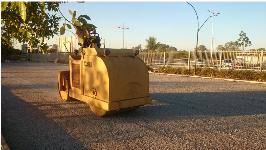
Figura 50 - Compactação dos Agregados
