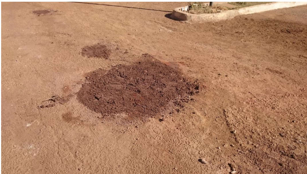
Figura 41 - Solo-Cimento Em Panelas
