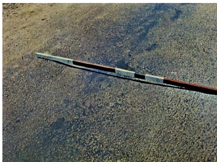
Figura 20 - Afundamento Local
