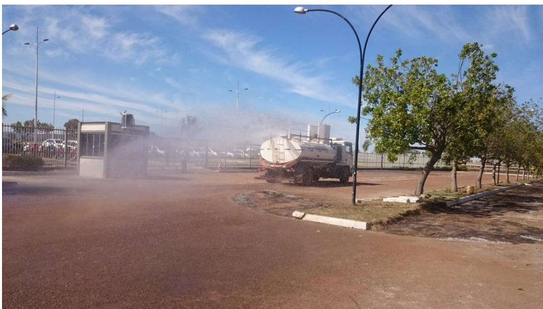
Figura 47 - Aplicação de Água
