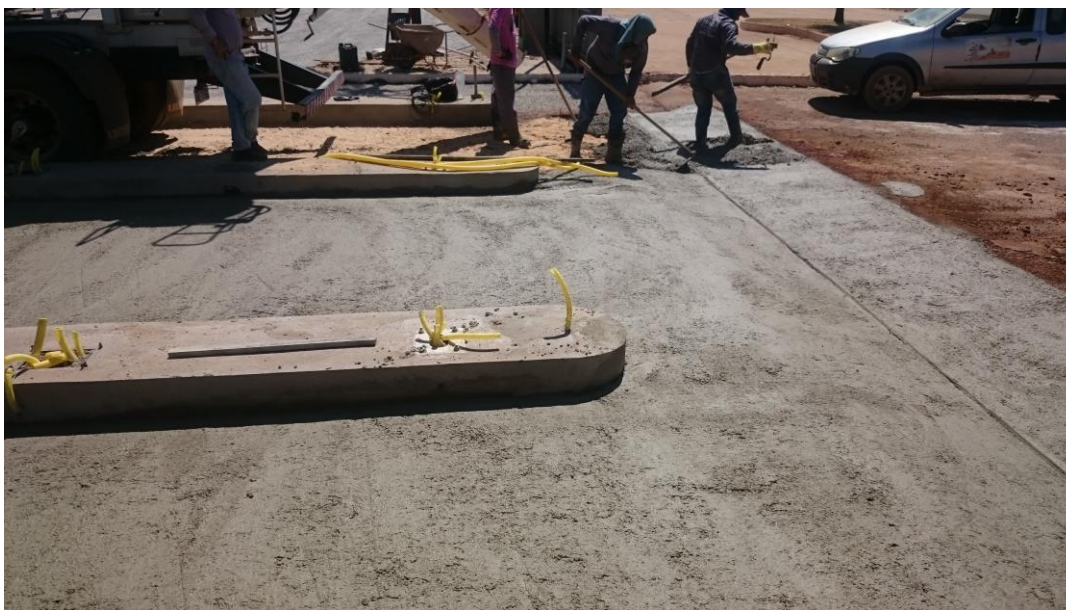
Figura 42 - Execução da Rampa de Acesso do Estacionamento
