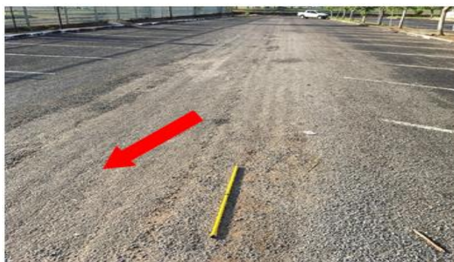
Figura 32 - Trinca Longitudinal
