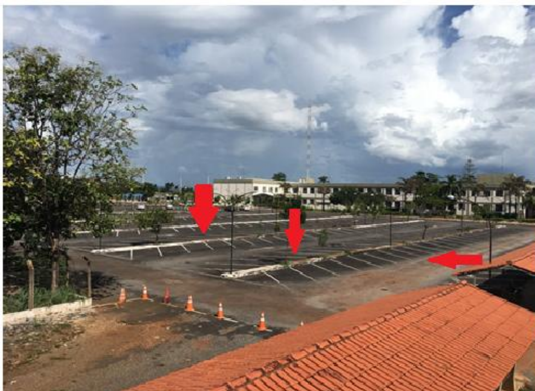
Figura 55 - Execução das Demarcações
