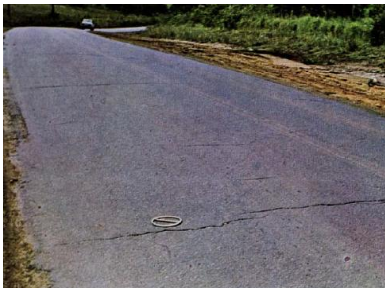
Figura 13 - Trinca Transversal
