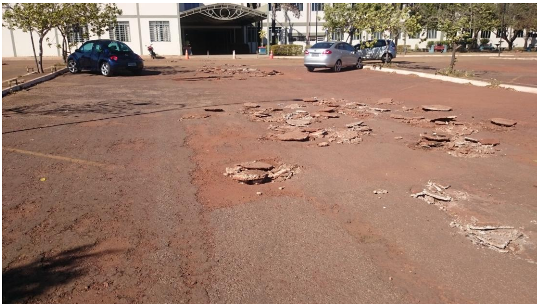
Figura 39 - Retirada de Tapa Buracos
