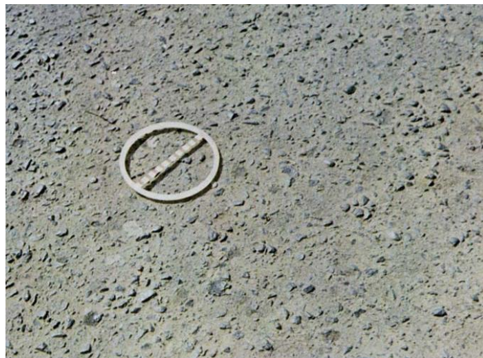
Figura 21: Desgaste.
