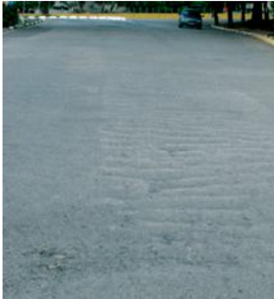
Figura 18: Ondulação / Corrugação.
