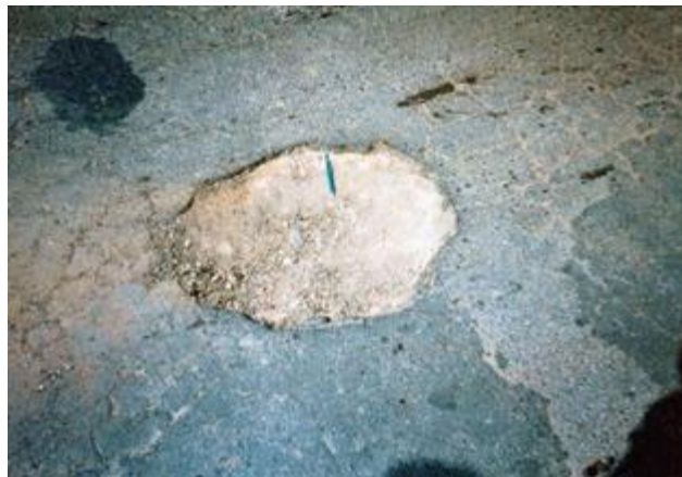
Figura 22: Panela ou Buraco.
