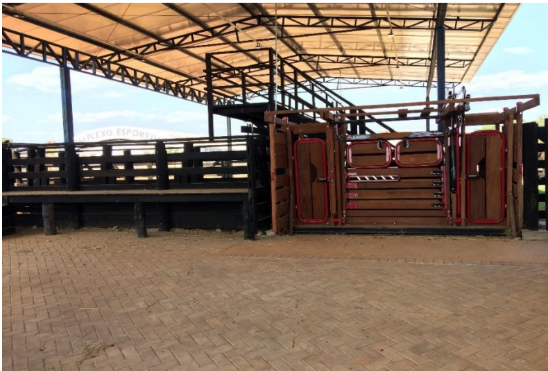
Figura 28 – Tronco de contenção
