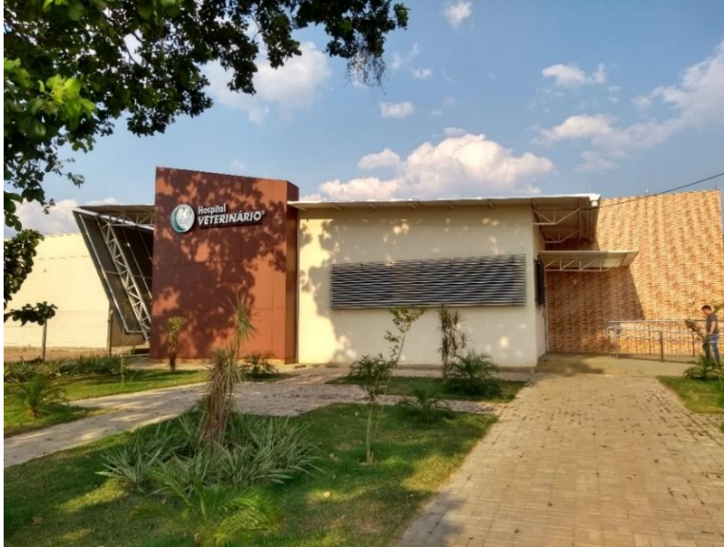
Figura 5 - Fachada do Hospital Veterinário CEULP/ULBRA.
