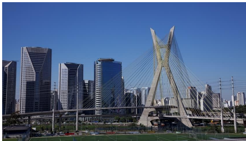
Figura 8 – Ponte Octavio Frias de Oliveira
