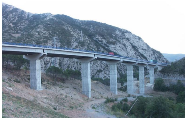
Figura 4 – Ponte em vigas.
