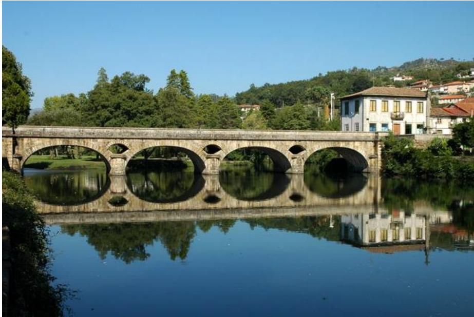
Figura 3 – Ponte de arcos de Valdevez.
