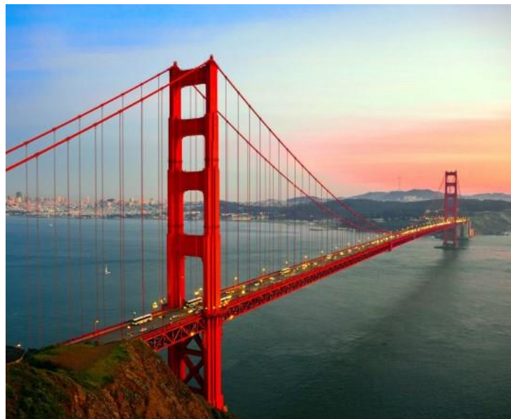
Figura 6 – Ponte Golden Gate
