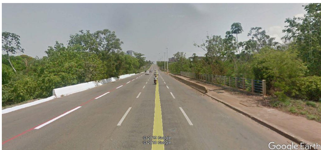
Figura 9 - Ponte em estudo.
