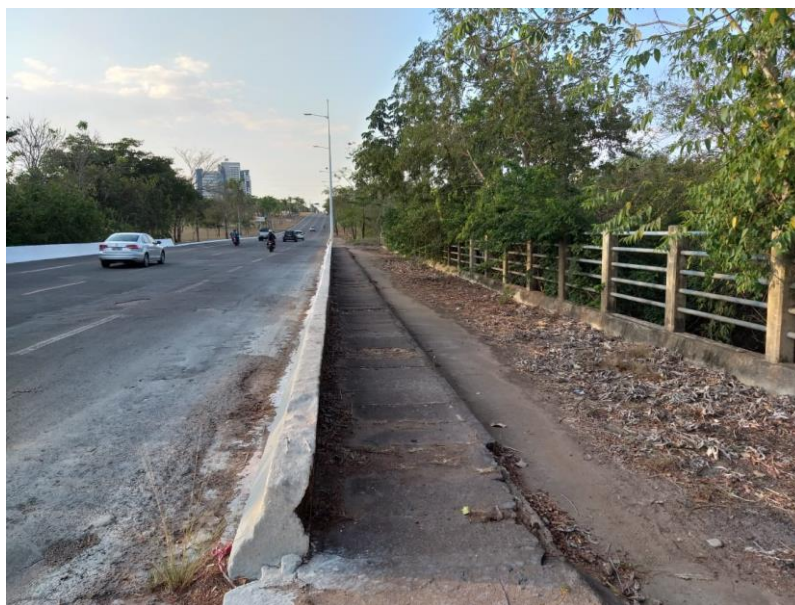
Figura 23 - Manchas de bolor e eflorescência no guarda corpo.
