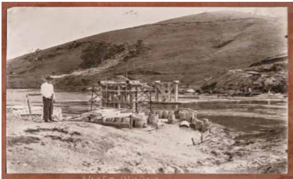
Figura 1 – Exemplo de primeiras Obras Públicas.
