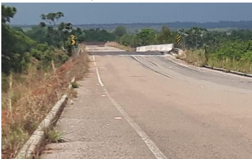
Figura 31 - Ponte inclinada.
