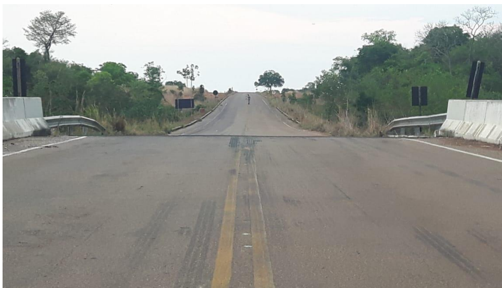
Figura 27 – Curva vertical que antecede a ponte
