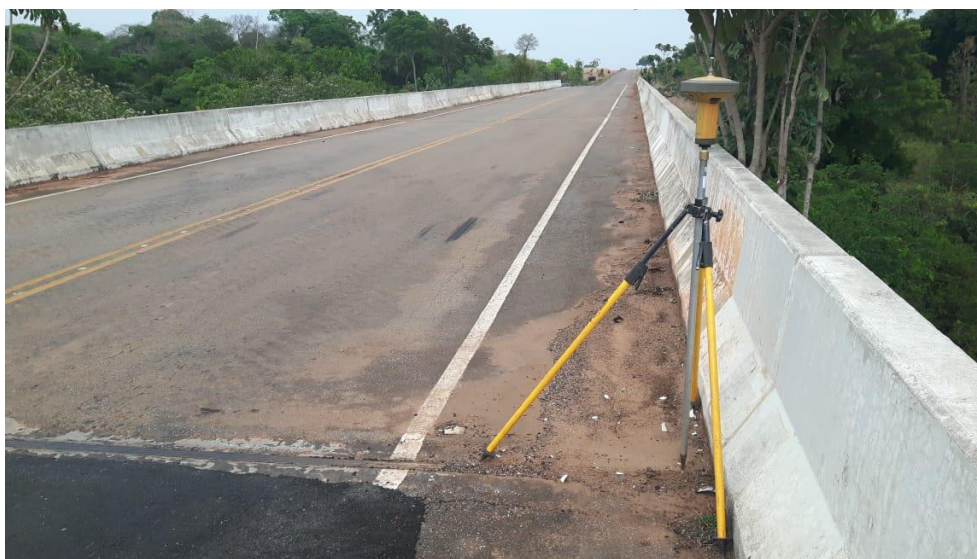
Figura 32 – Aparelho locado na extremidade da ponte.
