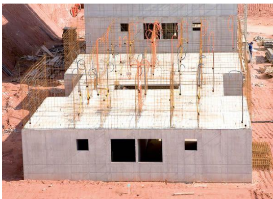
Figura 1 - Sistema Construtivo Parede de Concreto.
