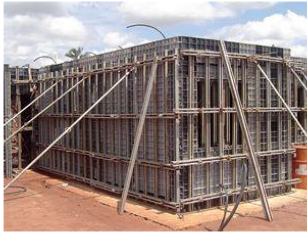
Figura 3 - Fôrma Metálica + Compensado.
