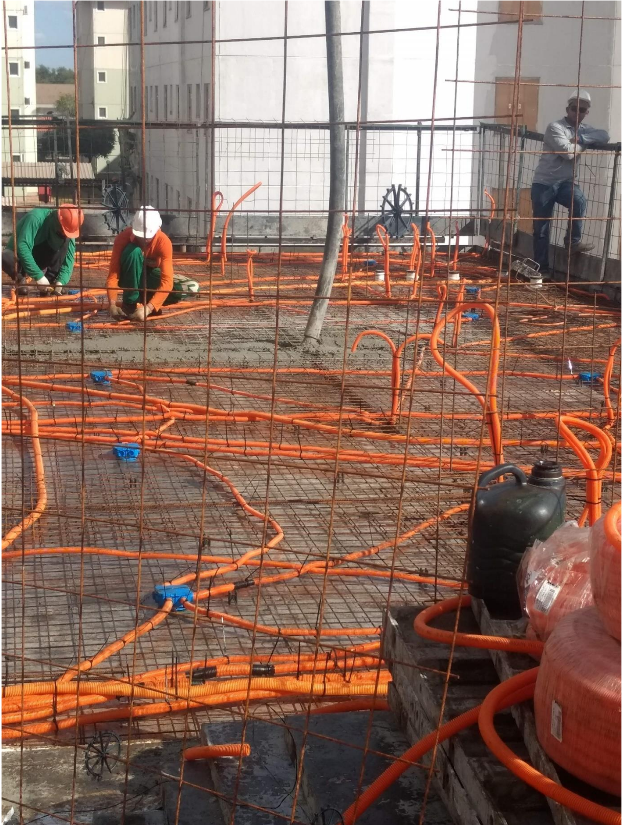
Figura 30 - Concretagem do pavimento.
