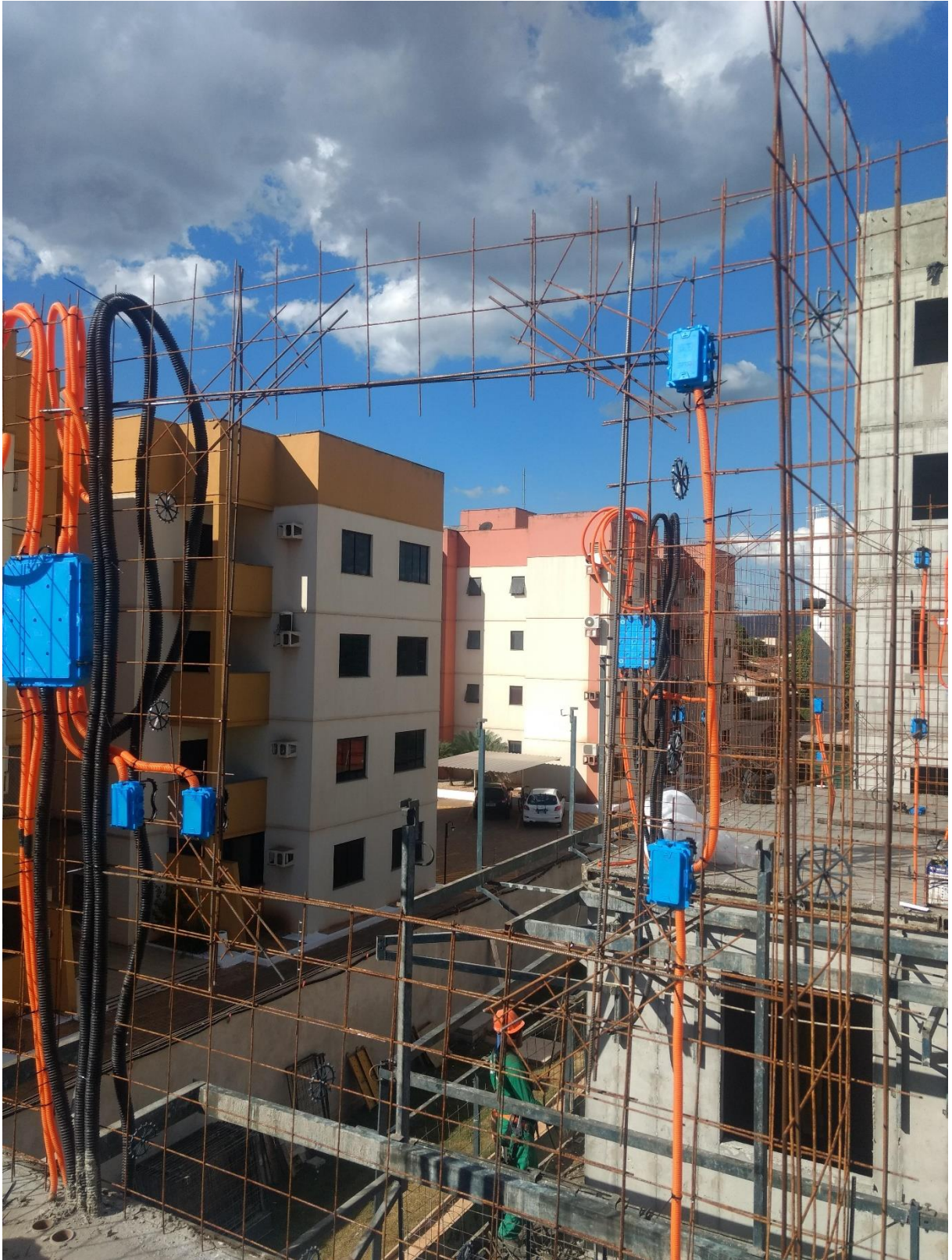
Figura 31 - Montagem da estrutura com reforço nos vãos.
