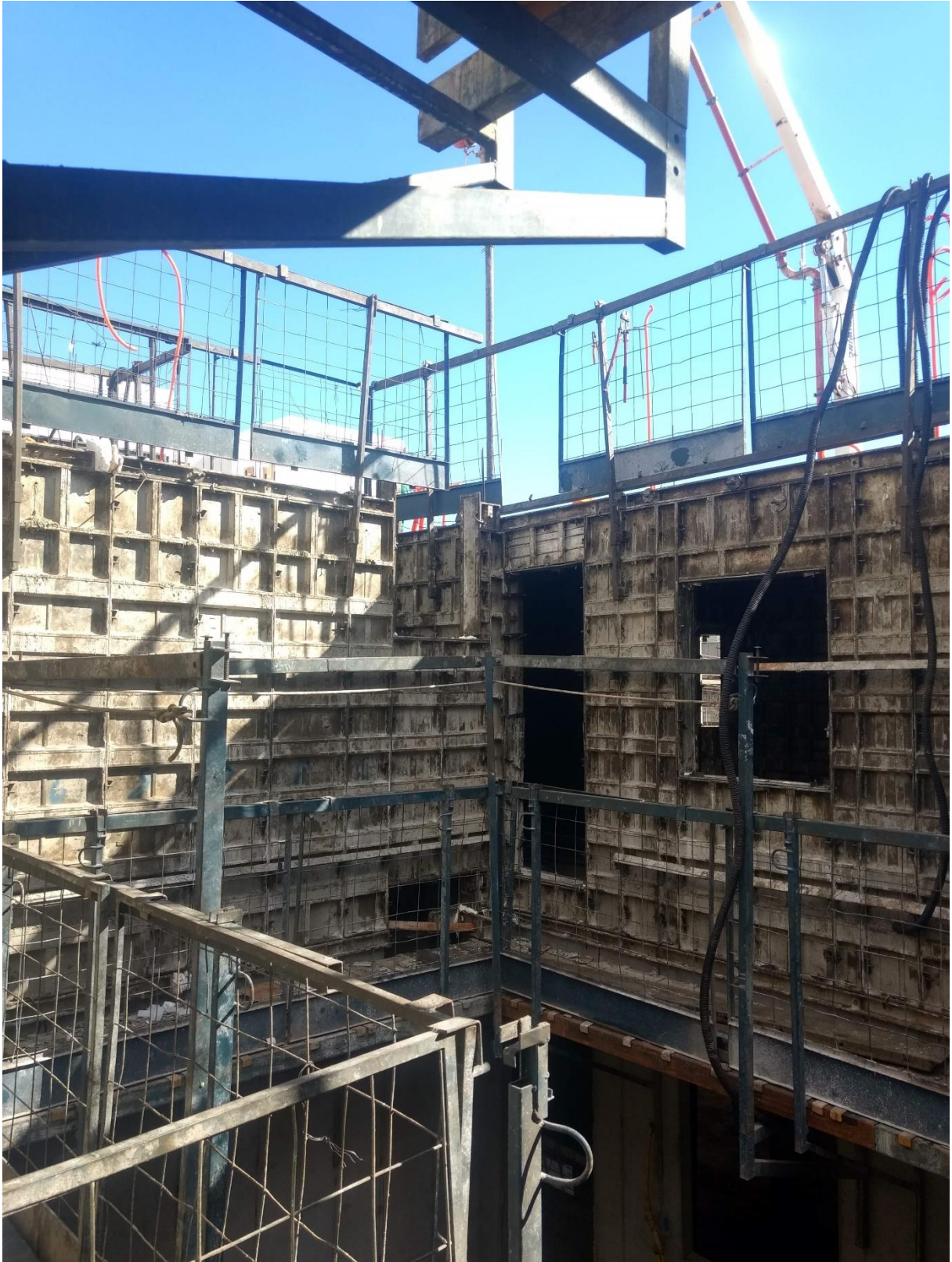
Figura 29 - Fôrma montada.
