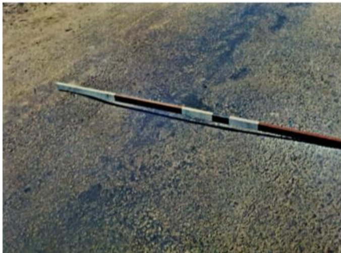
Figura 11 – Afundamento Local Fonte: DNIT 005/2003
