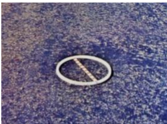
Figura 20 – Exsudação Fonte: DNIT 005/2003
