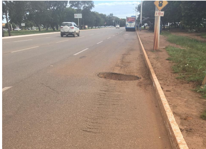
Figura 41 – Afundamento Plástico seguido de um Buraco Fonte: Acervo Pessoal (2019)
