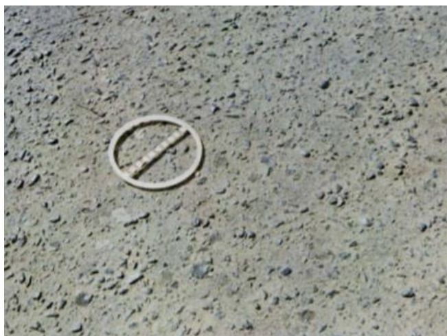
Figura 16 – Desgaste Fonte: DNIT 005/2003
