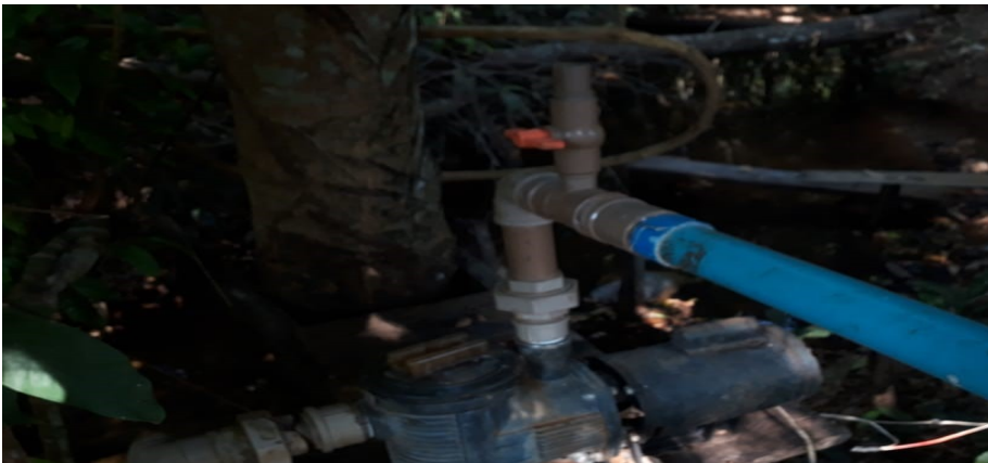
Imagem7: Conjunto motor bomba instalado. (Fonte; Autor)
