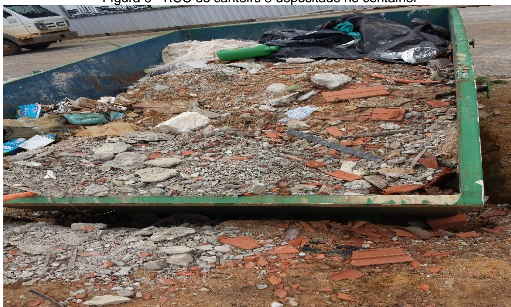
Figura 6 - RCC do canteiro 3 depositado no container
