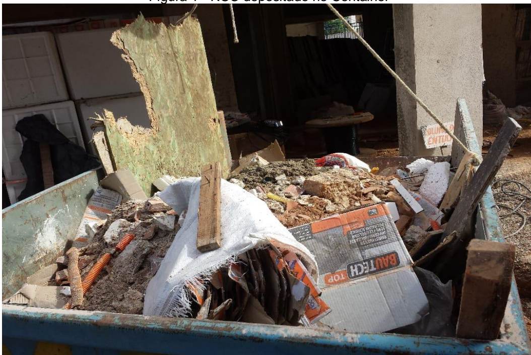
Figura 1 - RCC depositado no Container
