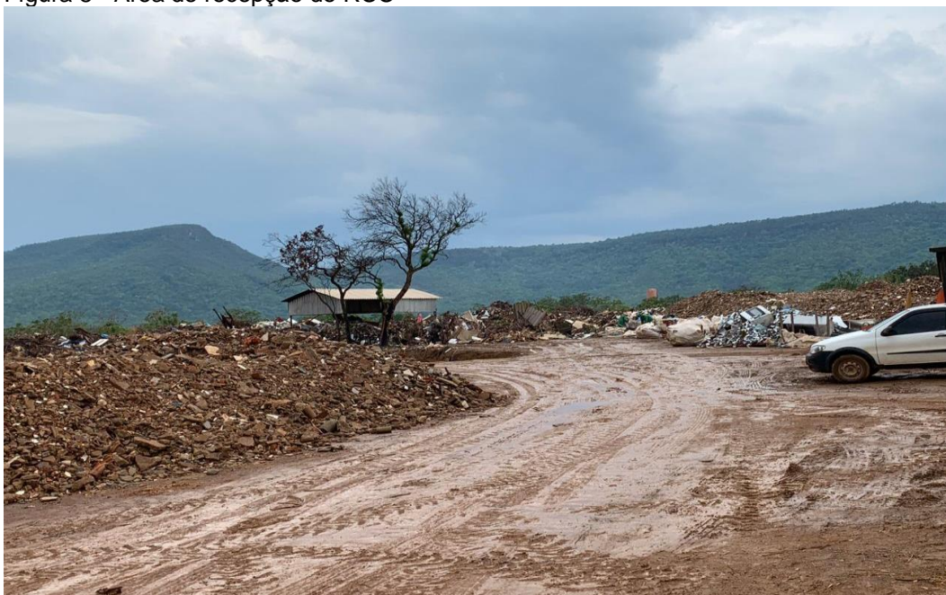
Figura 8 - Área de recepção do RCC
