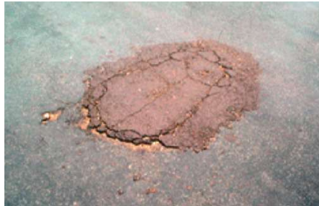
Figura 20– Remendo
