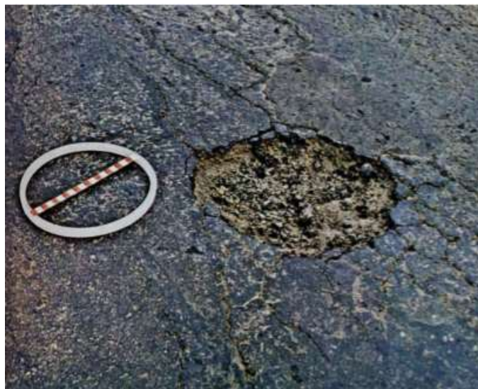
Figura 19– Panela/ buraco
