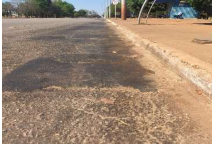
Figura 33- Remendo
