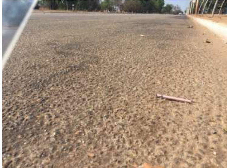
Figura 30- Desgaste
