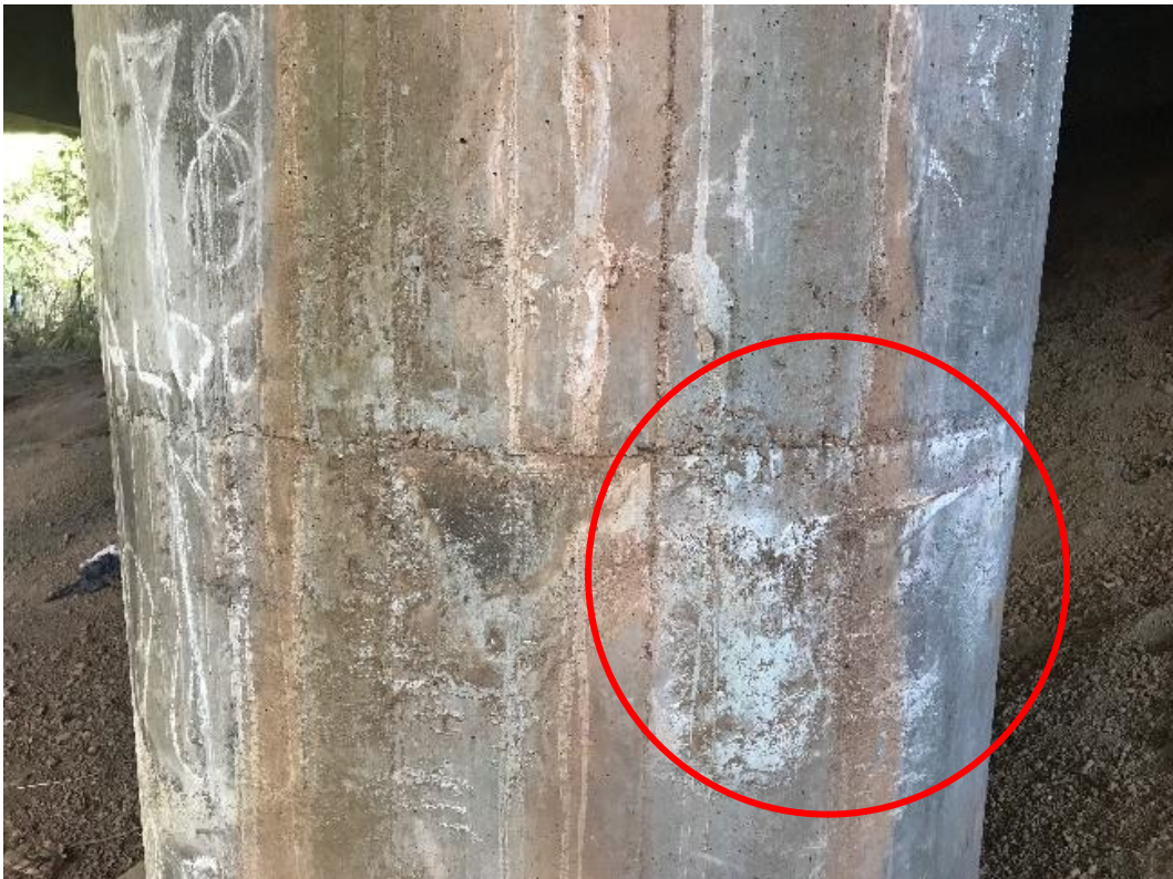
Figura 12 – Nicho de concretagem no Pilar P3.
