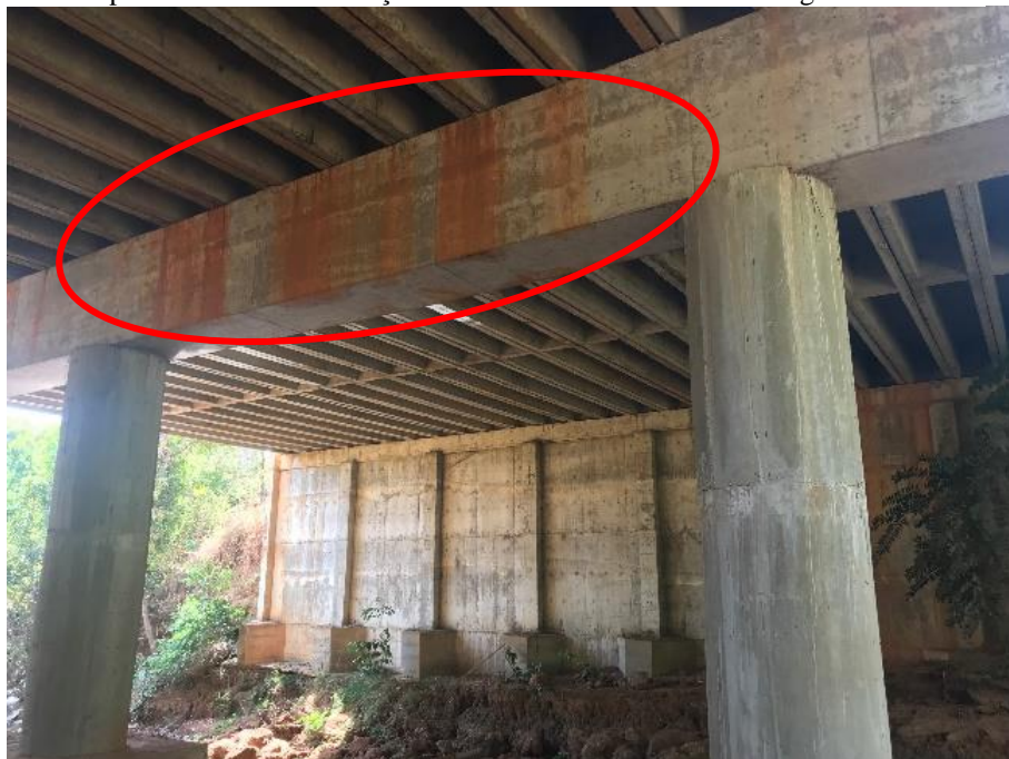
Figura 18 – Aparecimento de infiltrações e manchas de corrosão na Longarina L2.
