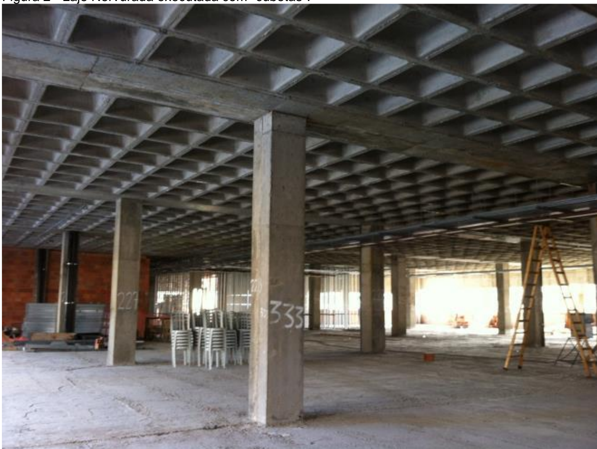
Figura 2 - Laje Nervurada executada com “cubetas”.
