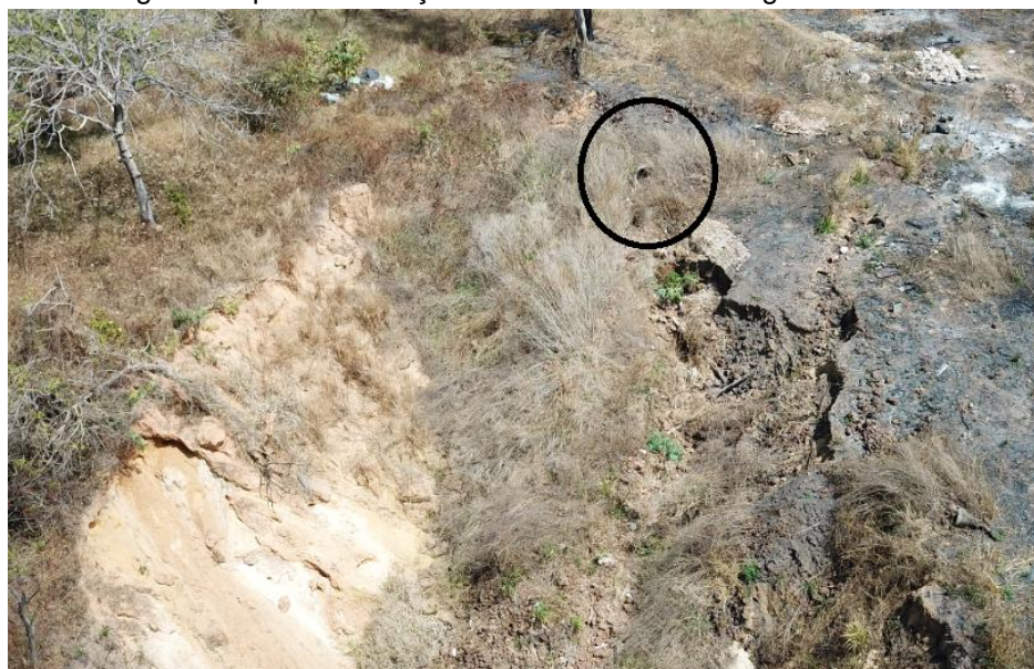
Figura 20: ponto de lançamento da rede de drenagem urbana.
