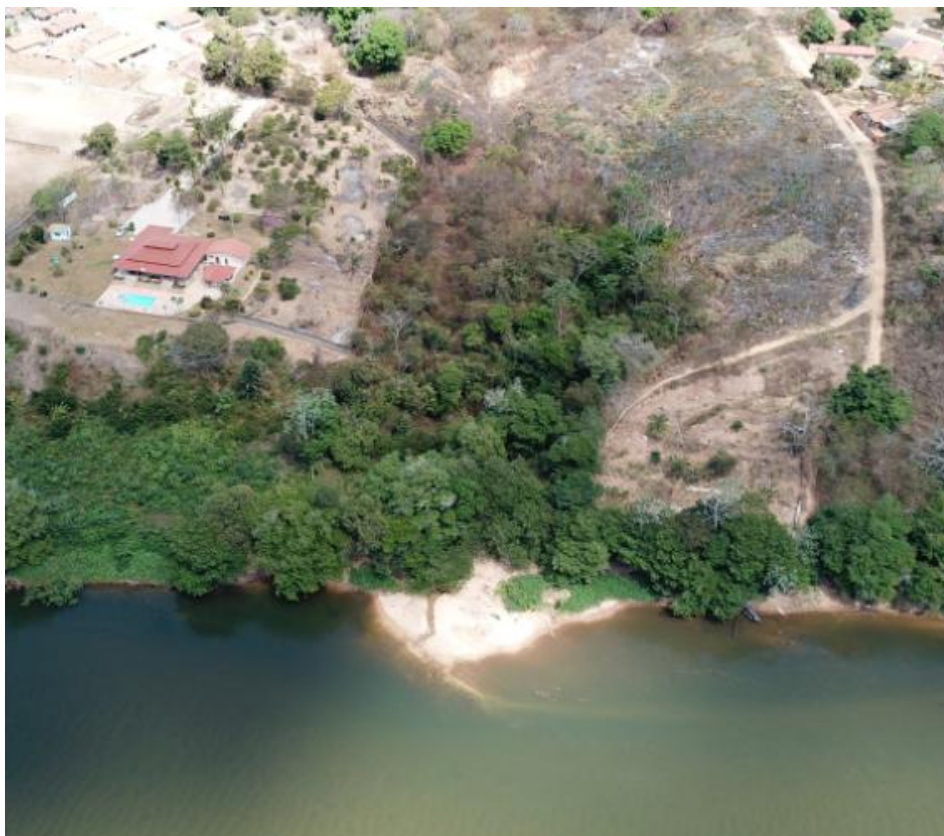
Figura 25: erosão no leito do rio sono.
