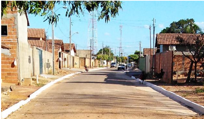
Figura 22: sistema de drenagem e pavimentação da principal via de acesso da área em estudo.
