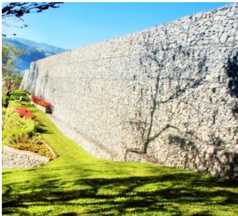
Figura 2: Exemplo de Gabião tipo Caixa
