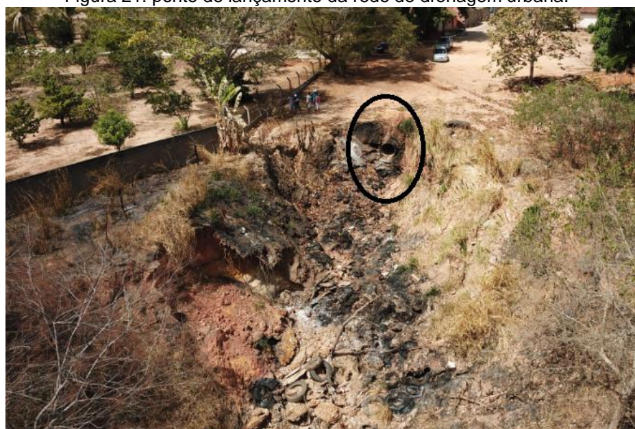
Figura 21: ponto de lançamento da rede de drenagem urbana.
