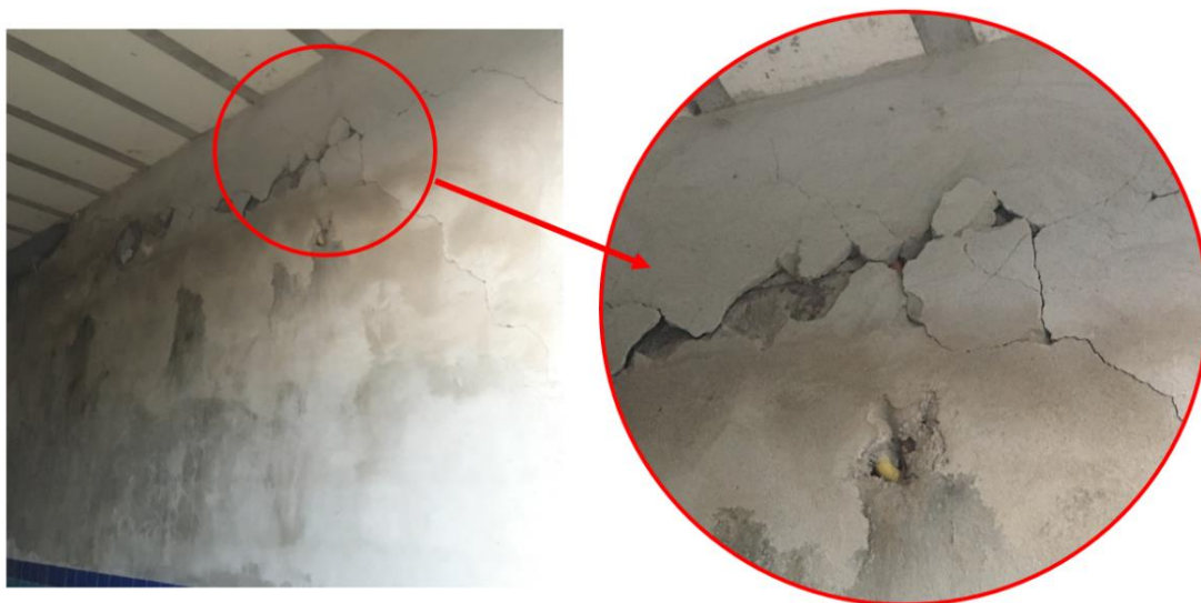
Figura 28 - Descolamento de revestimento argamassado encontrada na inspeção visual.
