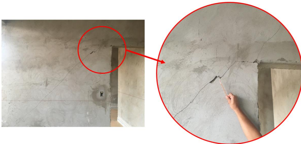
Figura 19 - Fissura encontrada na inspeção visual.
