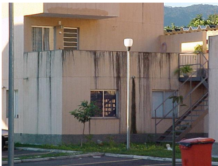
Figura 9 - Formação de bolor na fachada
