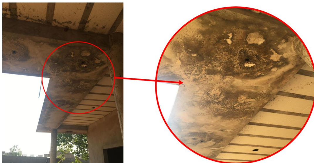
Figura 22 – Bolor encontrado na inspeção visual.
