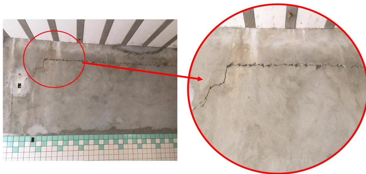
Figura 20 - Fissura encontrada na inspeção visual.
