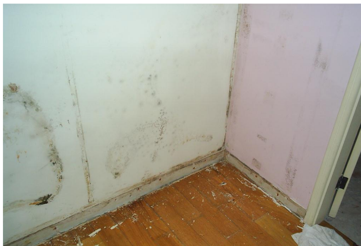
Figura 12 - Manchas oriundas da falta de impermeabilização
