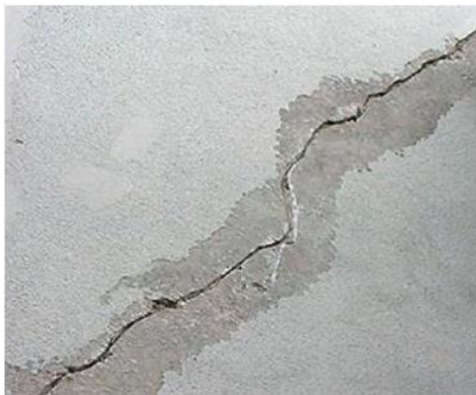
Figura 7 - Fissura geométrica
