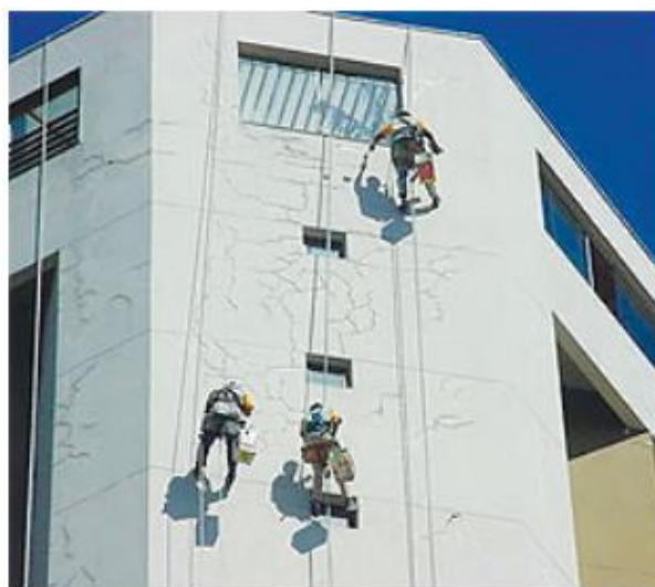
Figura 8 - Fissura geométrica
