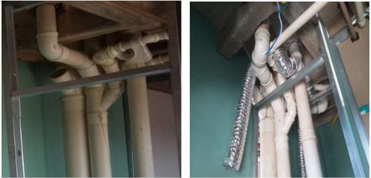
Figura 11: Foto antes da Correção do nível e depois da correção
