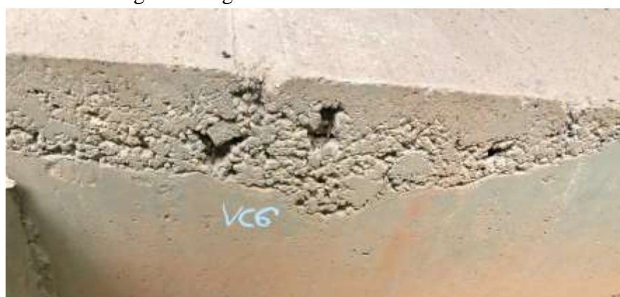
Figura 38 – Ninho de concretagem na viga de cinta
