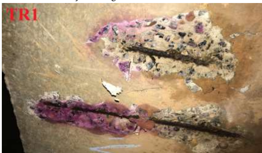
Figura 32 - Ensaio de carbonatação na Viga Transversal 1 da Ponte I.
