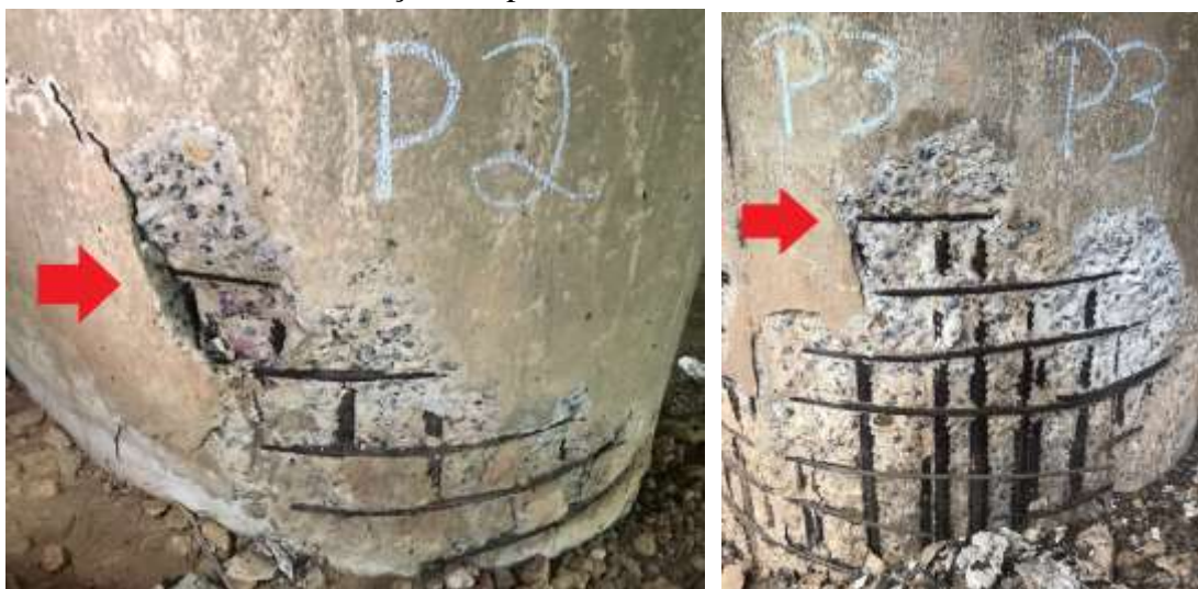
Figura 31 - Ensaio de carbonatação nos pilares
