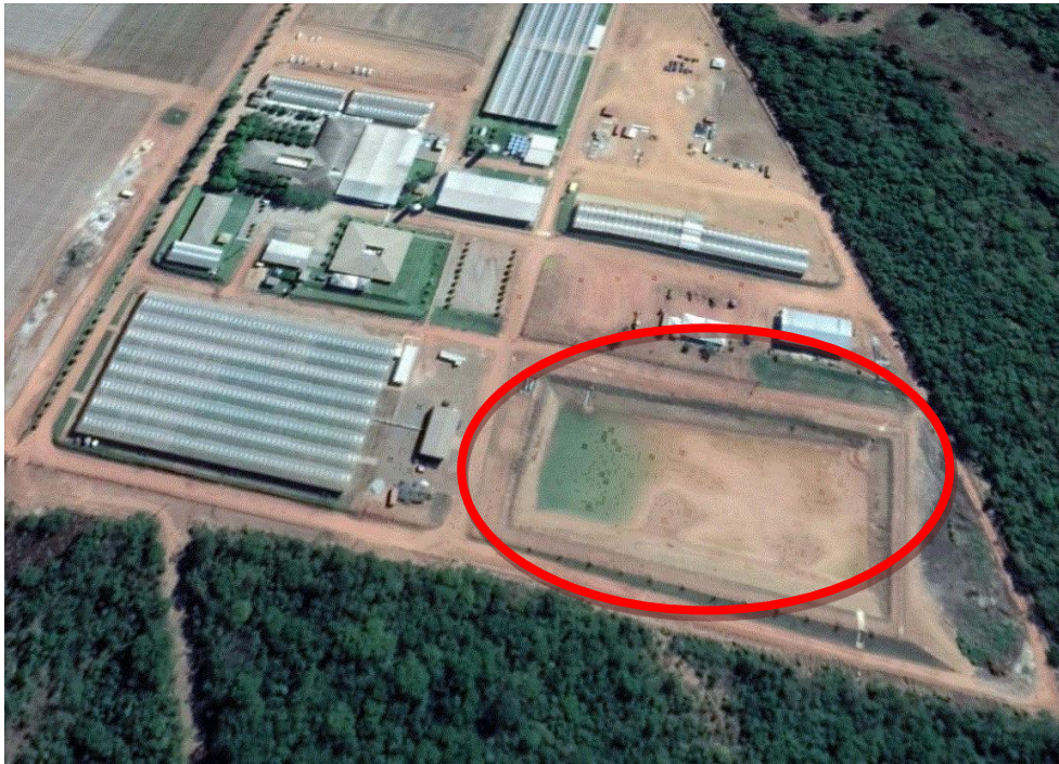
Figura 3: Local da construção da lagoa de resíduos.
