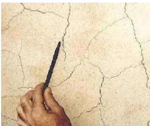
Figura 9 - Fissuras Mapeadas.
