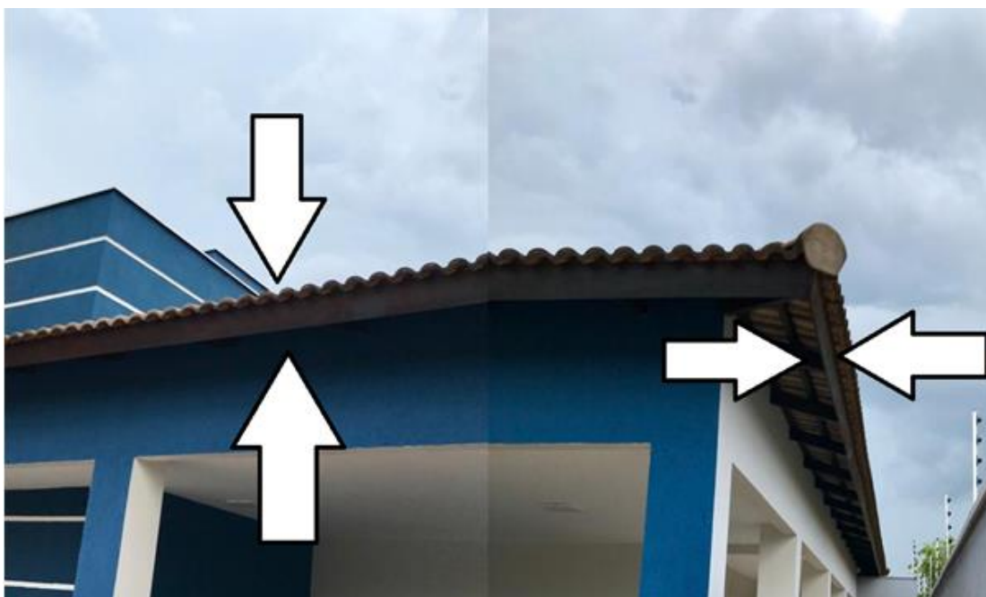
Figura 10: Locais das futuras calhas da residência (Panorâmica)
