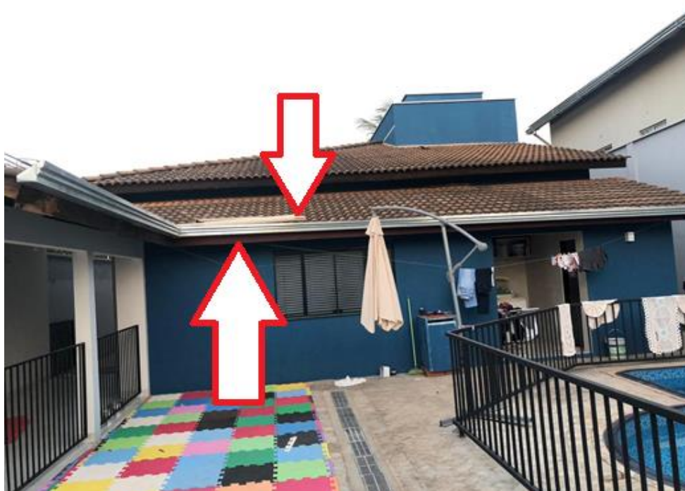
Figura 9: Calhas da residência
