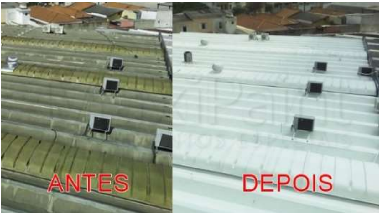
Figura 13: Aplicação de Tinta Térmica em Telhados.
