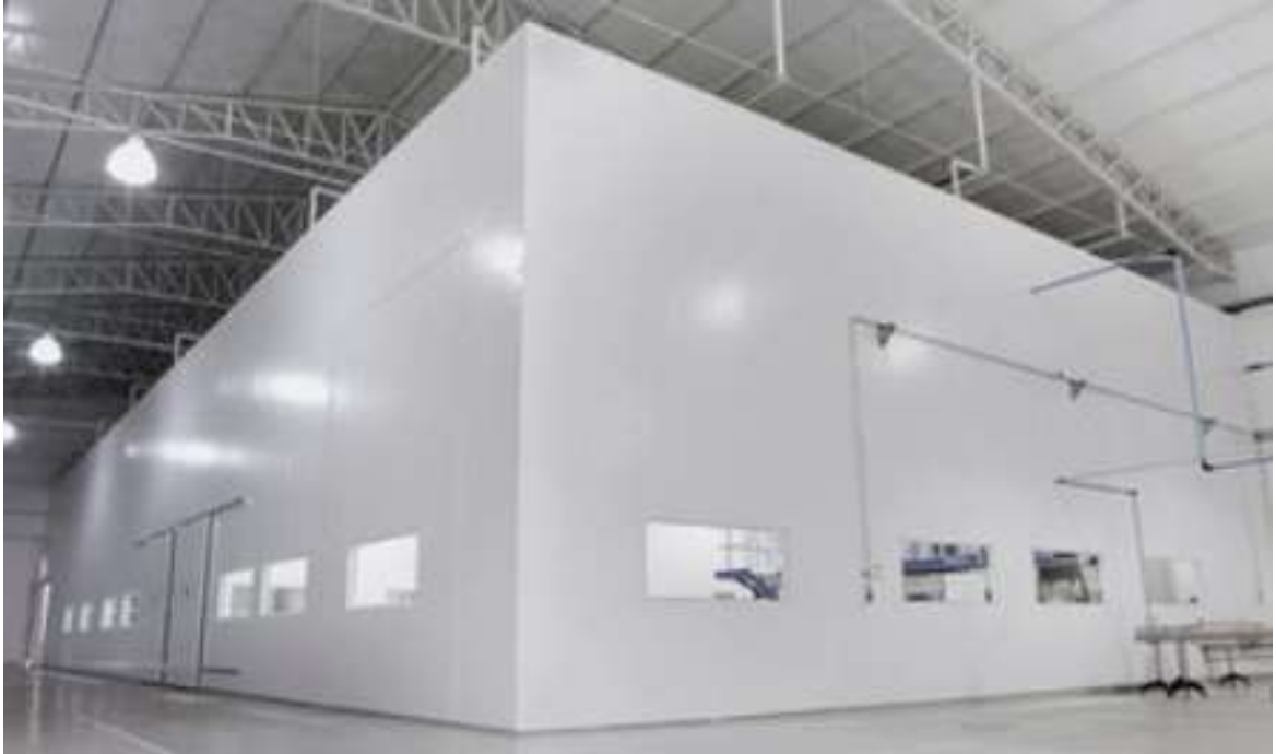
Figura 12: Aplicação de Tinta Térmica em Painéis.
