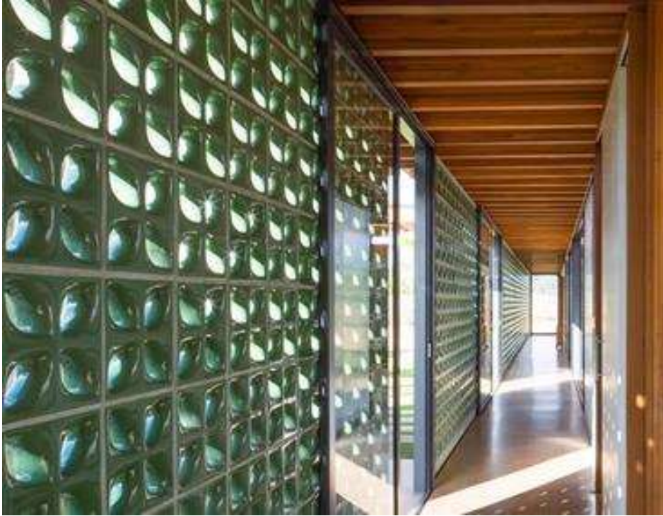
Figura 07: Sombreamento com Cobogó. (elemento modular vertical, com diversos formatos, que auxiliam na contenção de luminosidade e calor).
