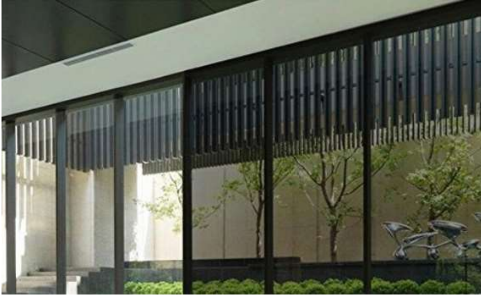
Figura 04: Aplicação de Película Reflectante. (vidraça clara com Película Reflectante e vidraça escura sem)
