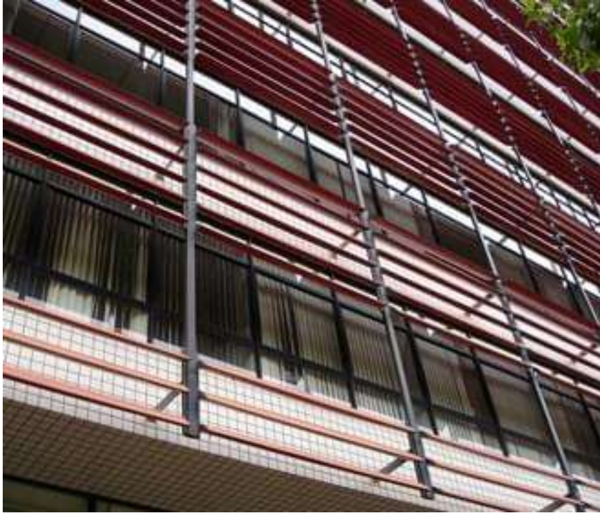
Figura 09: Sombreamento com Brise. (estrutura, geralmente metálica, instalada para a contenção da incidência de raios solares).
