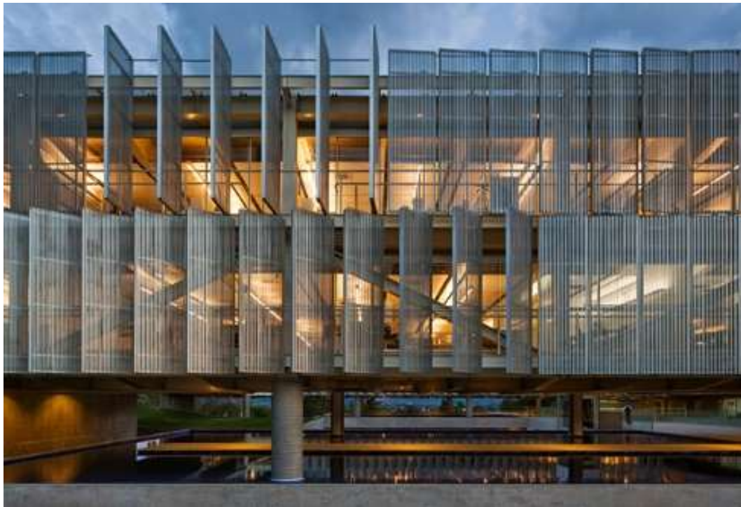
Figura 10: Sombreamento com Brise de Vidro. (estrutura de vidro instalada para a contenção da incidência de raios solares).
