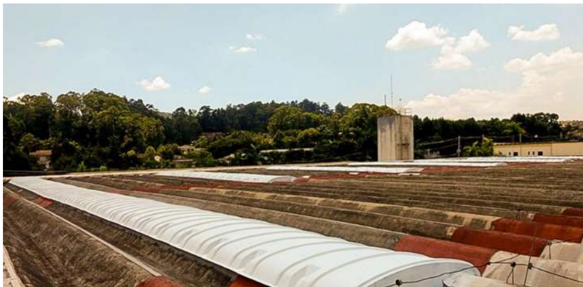
Figura 14: Aplicação de Tinta Térmica em Membranas.
