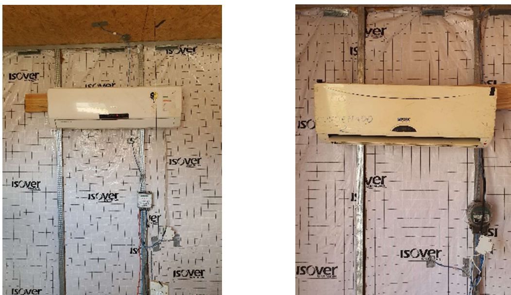
Figura 19 – Condicionador de ar Split12.000Btus Fonte: Célula 01 / Célula 02 (in loco - 2019)
