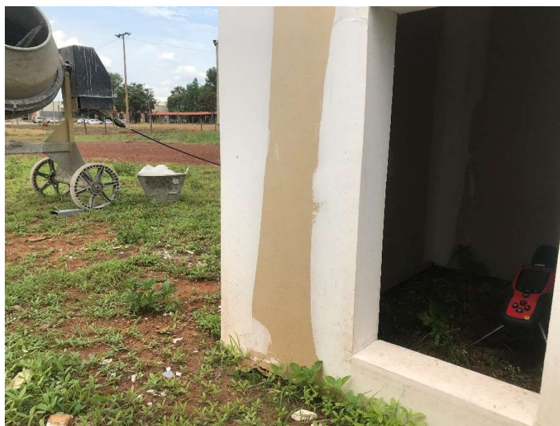
Figura 09 - Ensaio com betoneira
