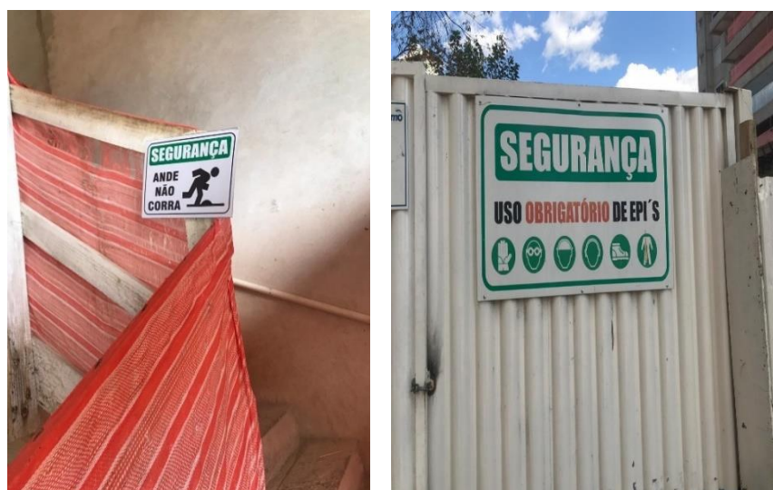
Figura 3. Sinalização no canteiro de obras.
