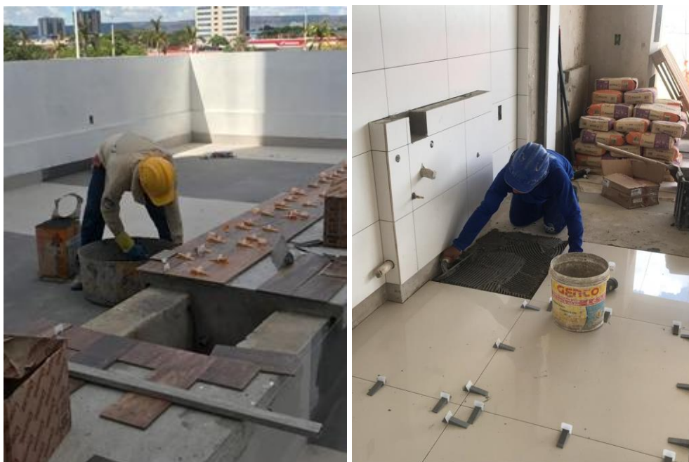
Figura 4. Assentamento de piso e revestimento.
