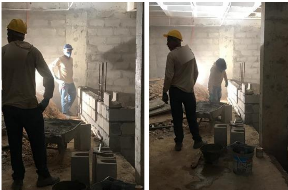
Figura 8. Assentamento de alvenaria
