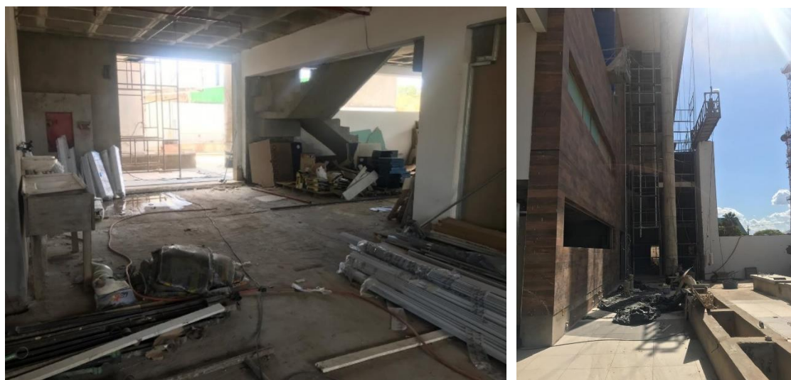
Figura 6. Organização da obra
