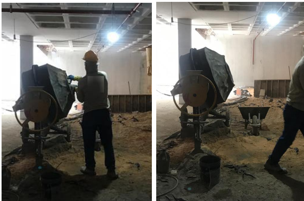
Figura 9. Preparo de concreto em betoneira
