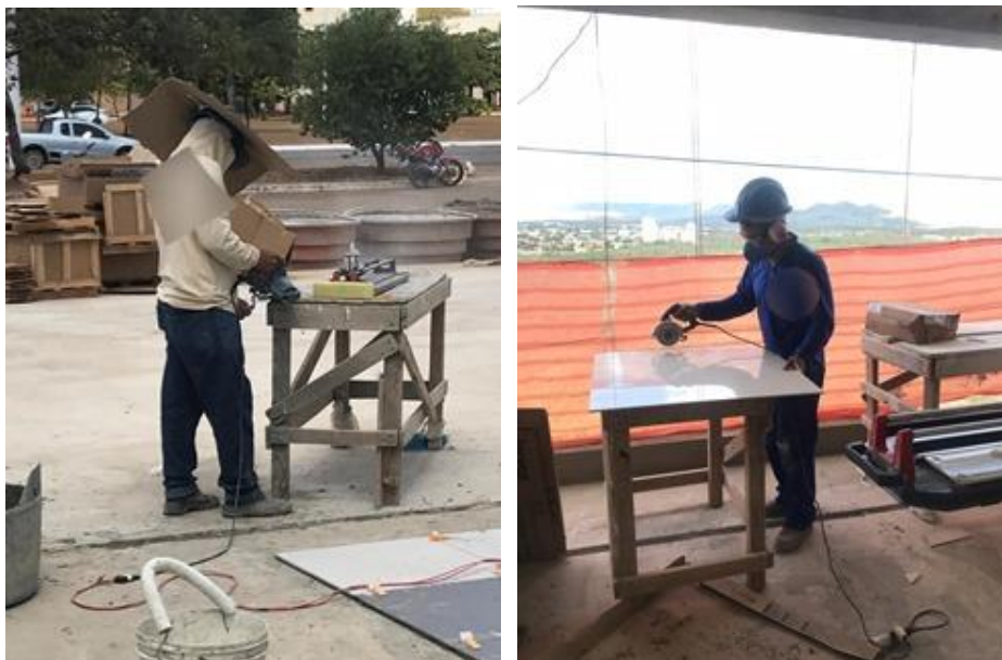
Figura 5. Recorte de peças cerâmicas.
