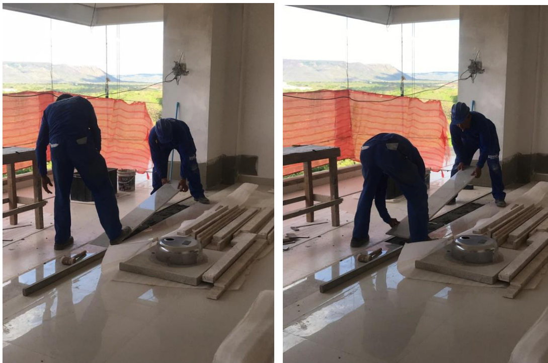
Figura 12. Assentamento de granito.
