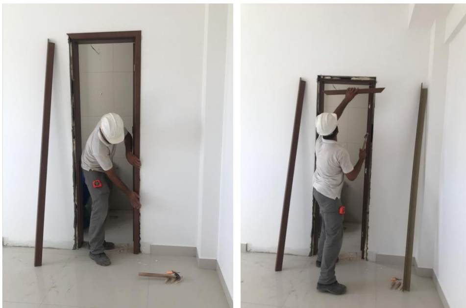
Figura 11. Assentamento de portas.
