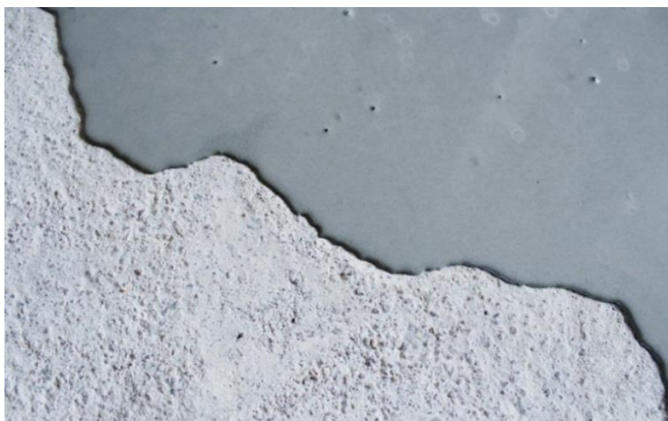
Figura 7: Camada de argamassa autonivelante sobre um contra piso
