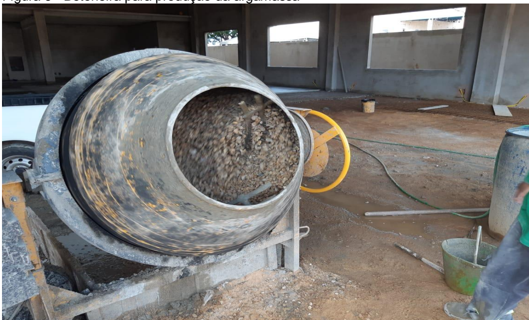
Figura 6 - Betoneira para produção da argamassa
