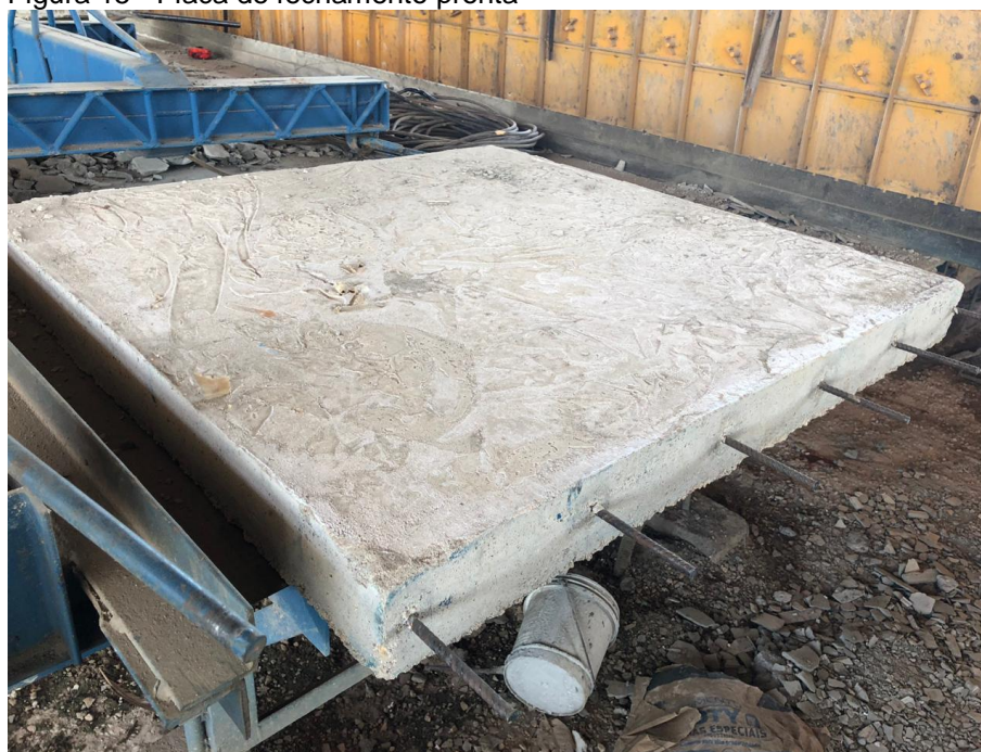
Figura 15 - Placa de fechamento pronta
