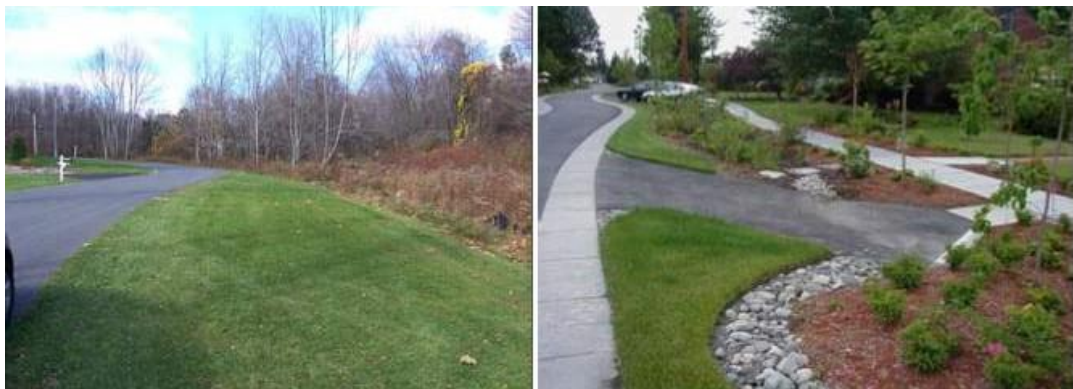
Figura 12 Na figura vemos uma faixa filtrante e uma vala gramada respectivamente
