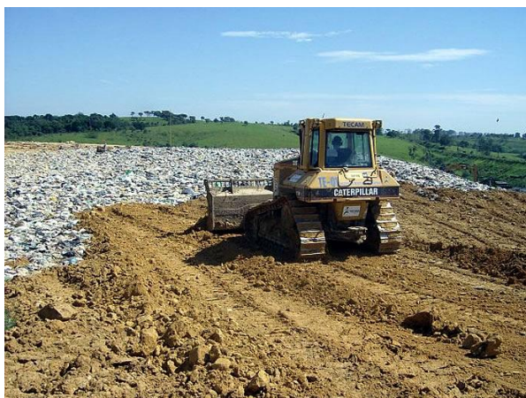
Figura 5 - Nivelamento e cobertura dos resíduos sendo realizados diariamente
