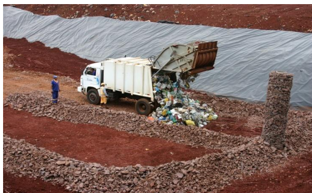
Figura 4 - Resíduos sendo descarregados na vala
