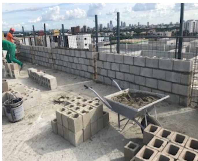
Figura 12 – Execução da Alvenaria Estrutural.
