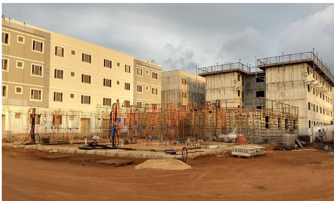
Figura 9 – Execução das Paredes de Concreto.
