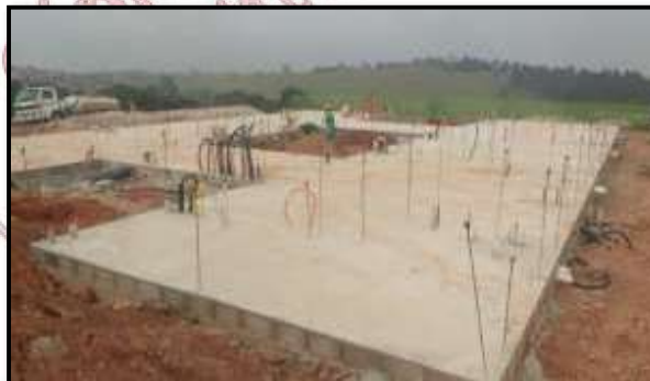
Figura 1- Piso pobre concluído com arranques para forma
