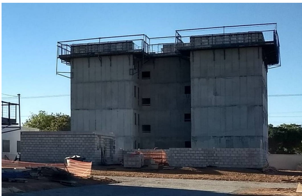
Figura 8 – Parede de Concreto X Alvenaria Estrutural.
