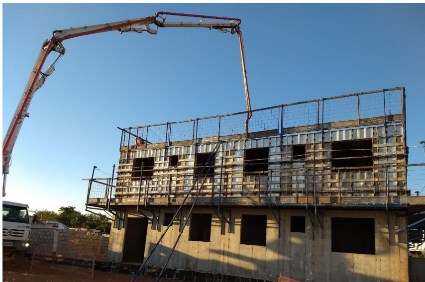
Figura 11 – Concretagem das Paredes e Laje.
