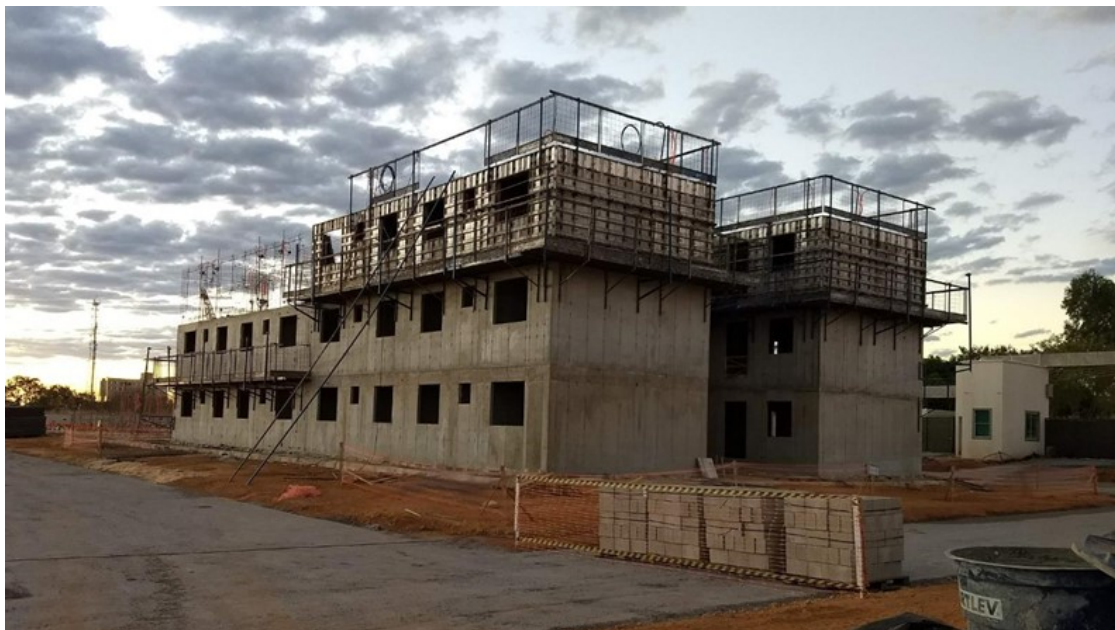
Figura 10 – Execução das Paredes de Concreto.
